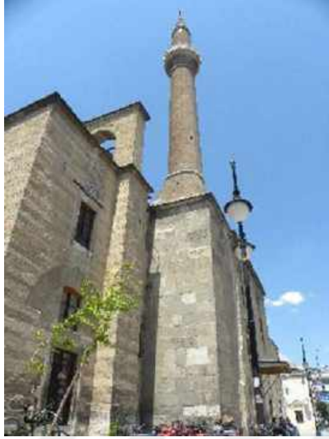
Resim 22: Şerafeddin Camii Doğu Cephe Bulunan Minaresi.
