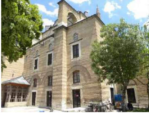
Resim 16: Batı Cephede Yer Alan Dikdörtgen Formlu Payanda Sistemi.
