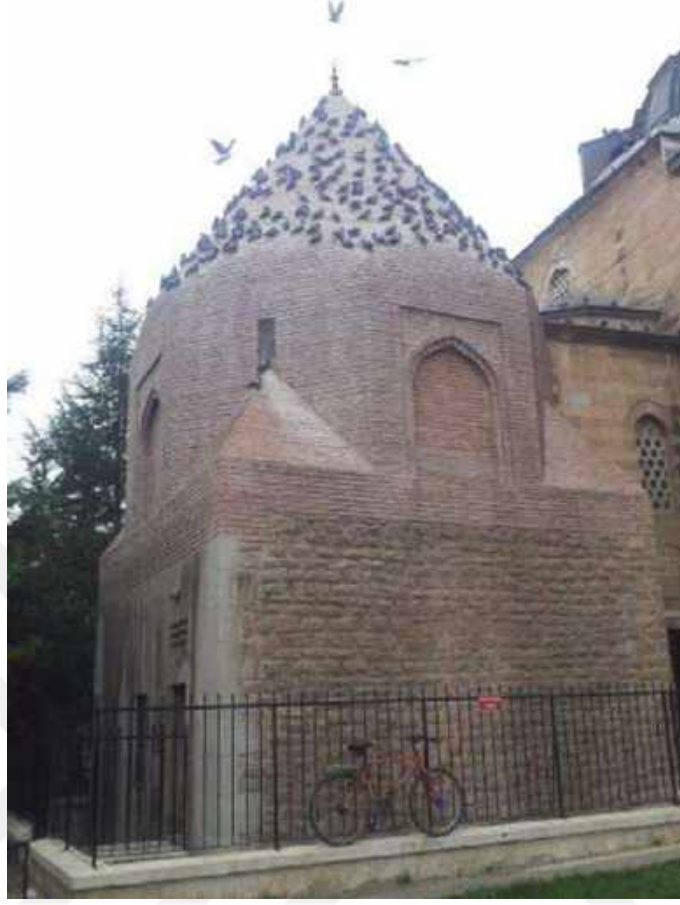
Resim 20: Şerafettin Camii Güney Cephede Bulunan Türbe.
