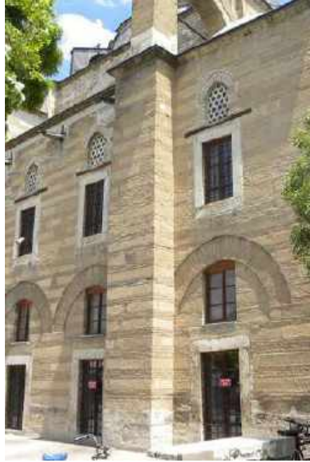
Resim 18a: Batı Cephe Pencere Sistemi.
