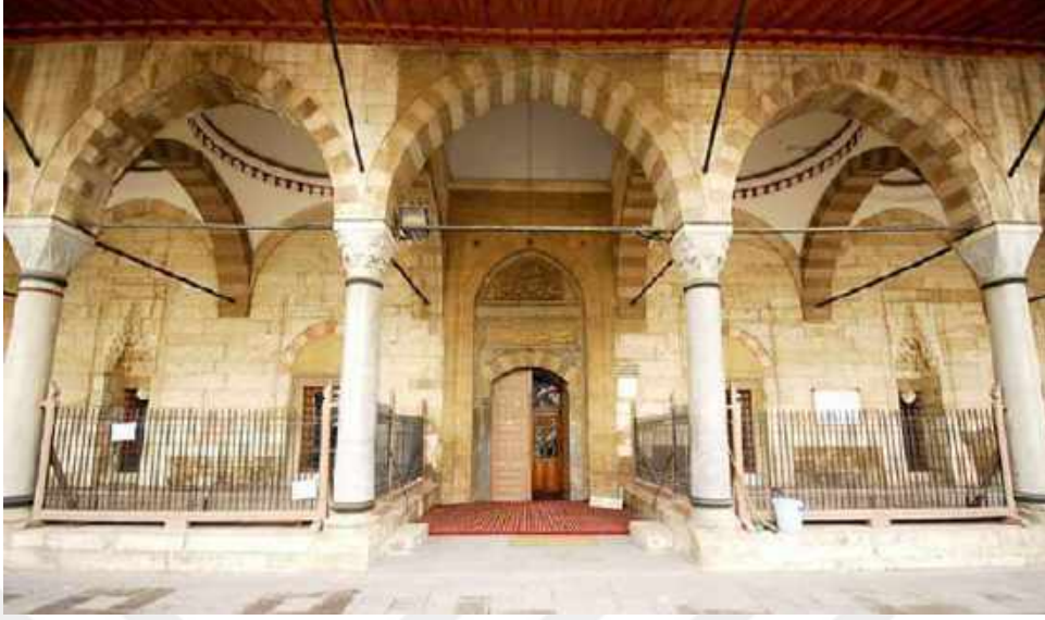
Resim 30: Şerafeddin Camii Kuzey Cephe Giriş Taç Kapı.
