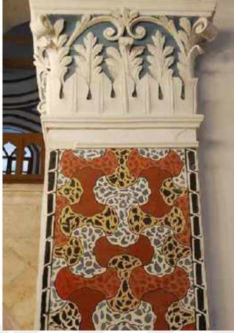
Resim 42: Şerafettin Camii Mihrap Bölümü Üst Örtü Kemer Taşıyıcı Sistemi Sütun Başlıkları.
