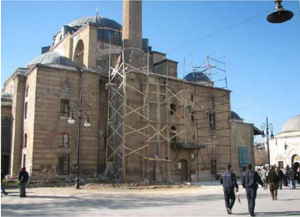
Resim 23: Şerafeddin Camii Doğu Cephe Bulunan Minaresi.
