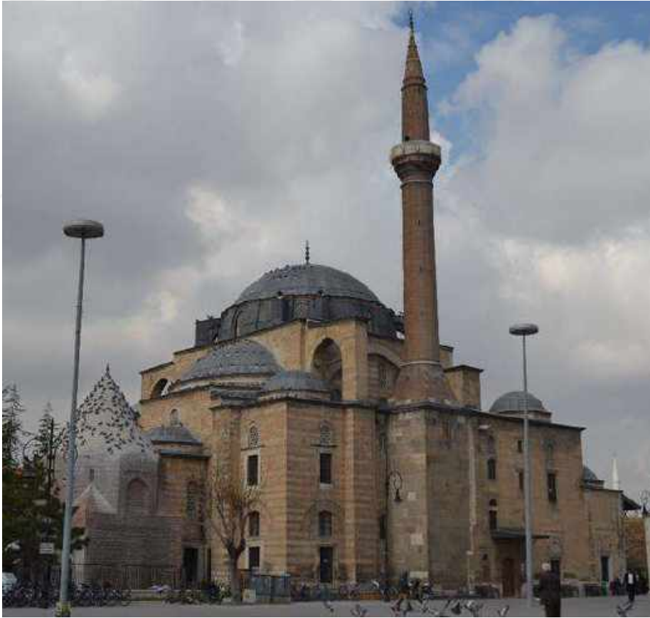
Resim 19: Şerafettin Camii Güney Cephede Bulunan Türbe.
