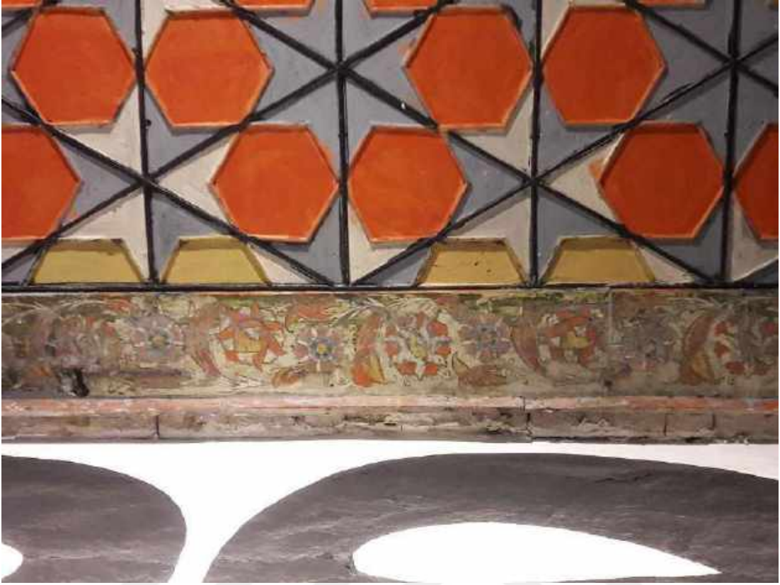
Resim 169: Mevlana Türbesi Ahşap Üzeri Kalem İşi Süslemesi.
