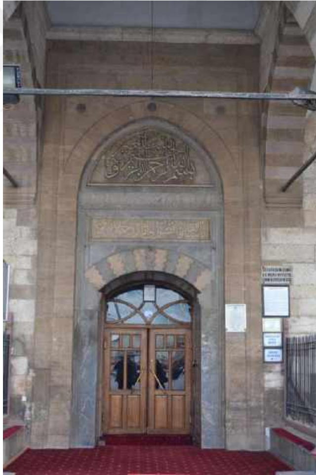
Resim 31: Şerafeddin Camii Kuzey Cephe Giriş Taç Kapı.
