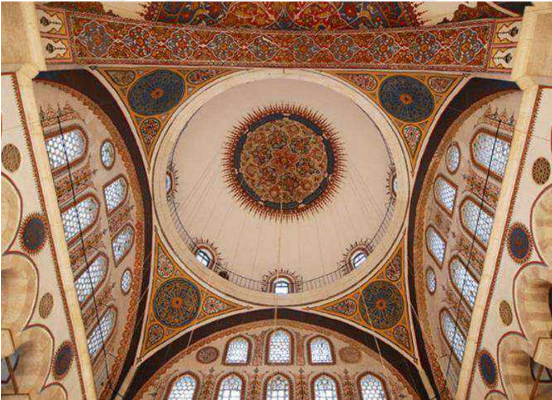
Resim 81: Doğı-Batı-Kuzey Yönlere Yer Alan Perde Duvarlar.
