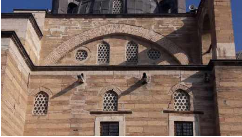
Resim 18b: Batı Cephe Pencere Sistemi.
