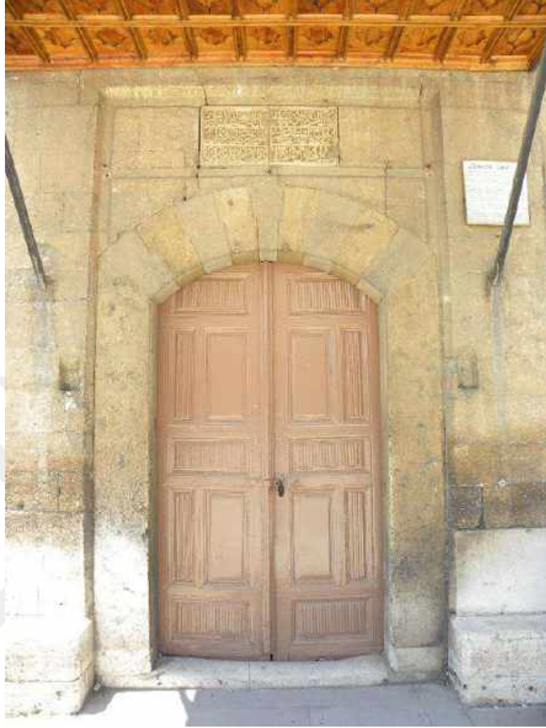
Resim 24: Şerafeddin Camii Doğu Cephede Bulunan Harim Girişi.
