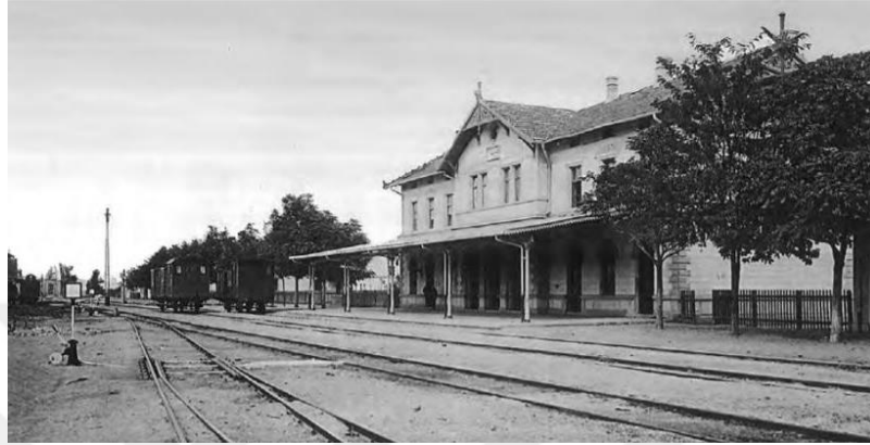
Şekil 24. Konya Eski Gar Binası (Özyüksel, 2013).
