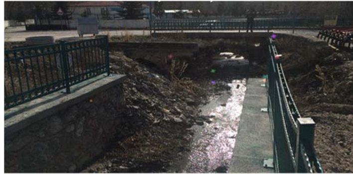
Şekil 1-6. Konya Kulu Bozan Mahallesi Taşkın Koruma Tesisi (Cengiz, 2020)
