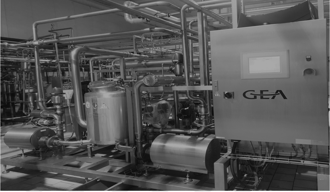
Şekil 3.2.4.2.Ultrafiltrasyon (Marka: GEA)
