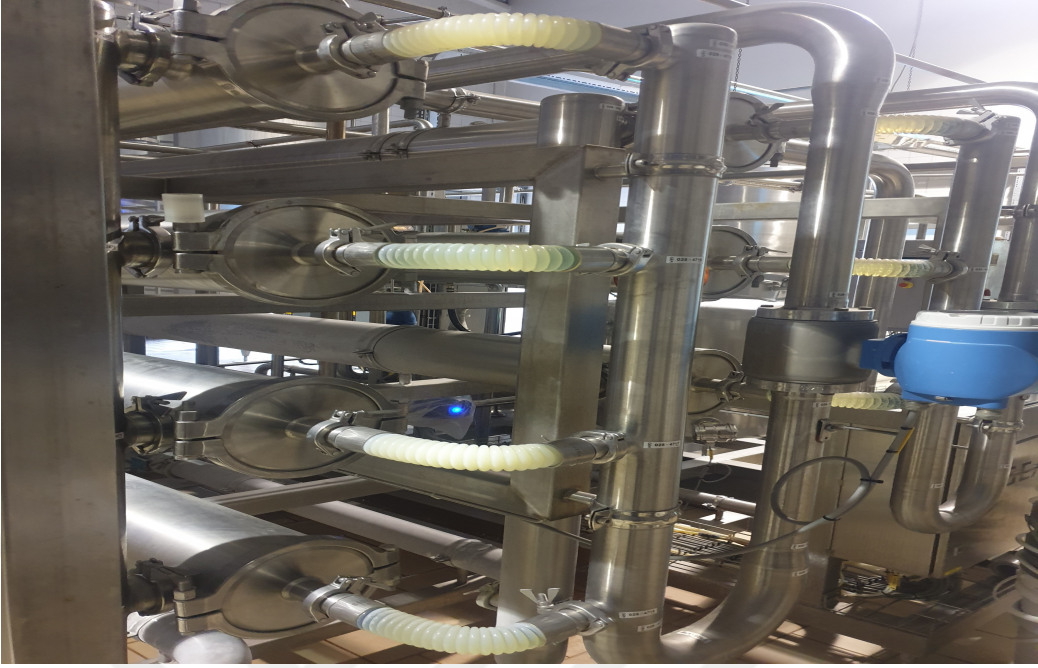
Şekil 3.2.4.4.Membran filtrelerden süzölen permeat
