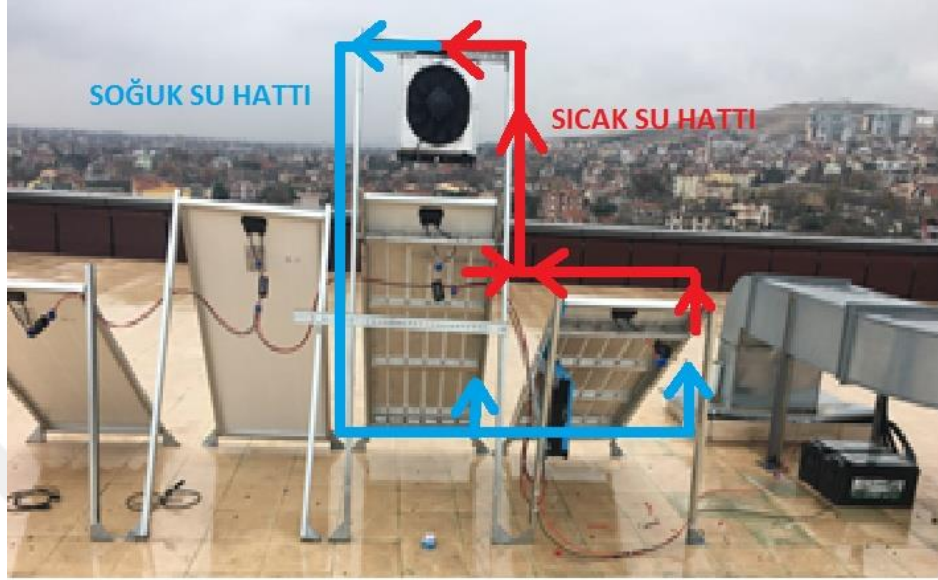
Şekil 3.5. Su soğutma sisteminde suyun akış yönü
