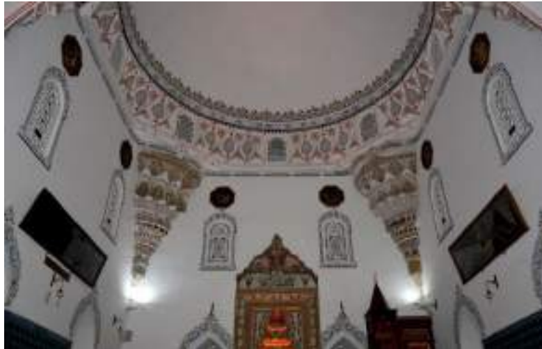
Resim 41: Muradiye Camii, Restorasyon sonrası mihrap duvarı, 2019 (KAMACI, Ayşegül)
