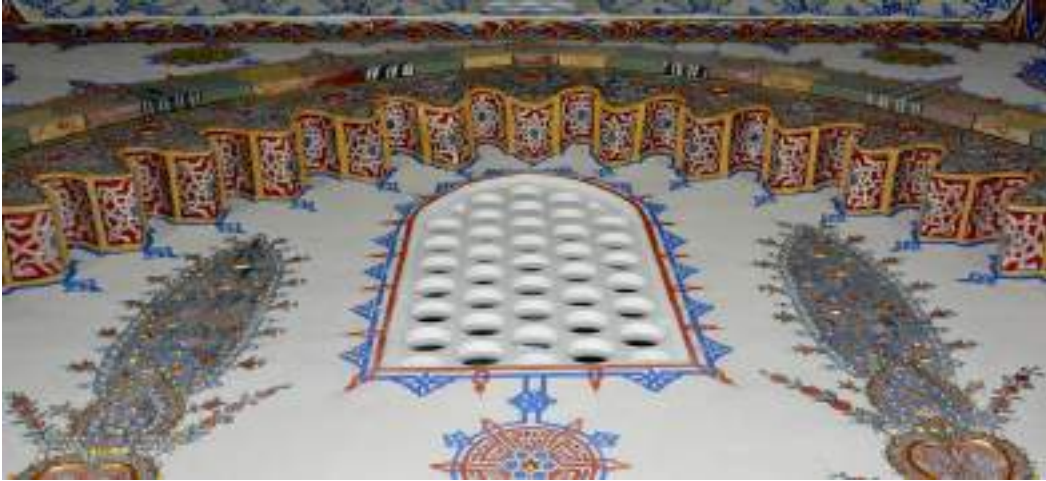
Resim 187: Kuzey Cephe 3. Kademe (b1), 2019 (KAMACI, Ayşegül)
