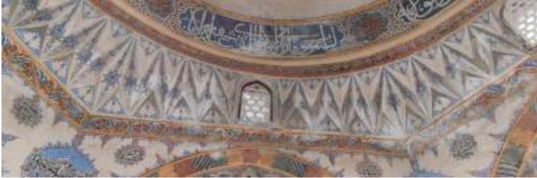
Ek 8: Restorasyon öncesi Türk üçgenleri (Bursa Cem Sultan Türbesi Mevcut Durum ve Raspa Sonrası Kalem İşi Rölöve Raporu)
