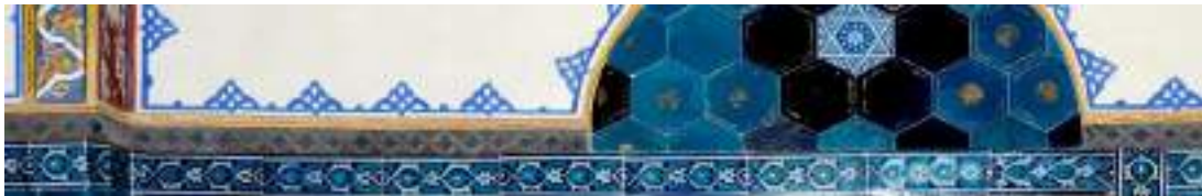
Resim 154: Güneydoğu Cephe 2. Kademe (a8), 2019 (KAMACI, Ayşegül)
