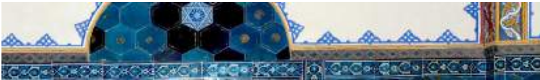
Resim 170: Kuzeydoğu Cephe 2. Kademe (a8), 2019 (KAMACI, Ayşegül)
