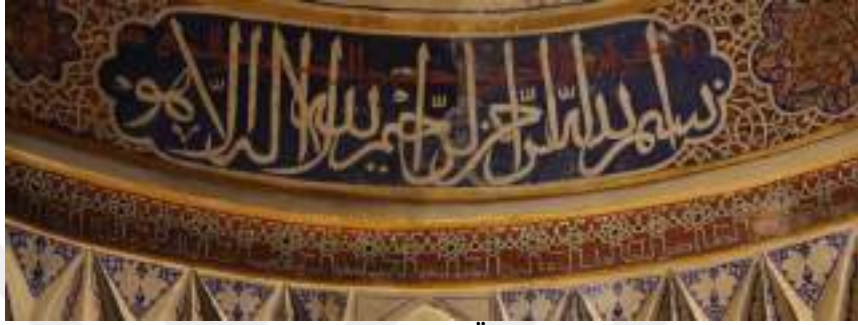
Resim 233: 2015 Restorasyon Öncesi, Kubbe Kasnağı
