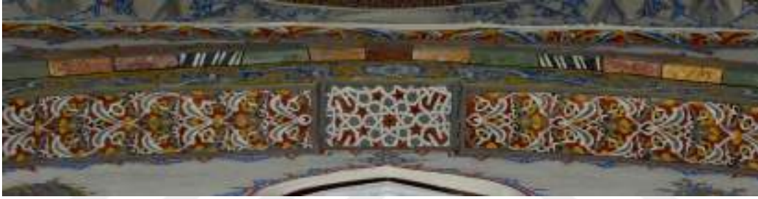
Resim 220: Güneybatı Cephe 3. Kademe (b1), 2019 (KAMACI, Ayşegül)
