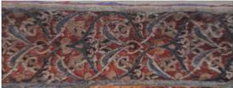
Resim 232: 2015 Restorasyon Öncesi, Bursa Kemeri İç Bünyesi
