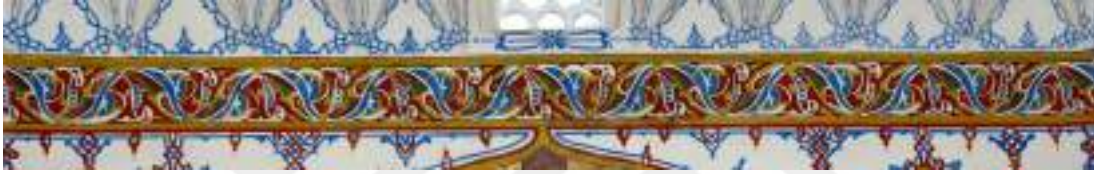
Resim 123: Güney Cephe 1. Kademe, 2019 (KAMACI, Ayşegül)
