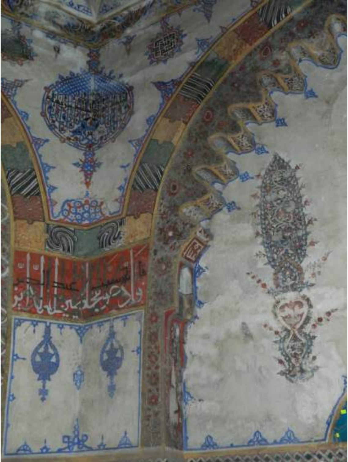
Ek 23: Restorasyon öncesi kuzey cephe (Bursa Tarihi Kültürel Miras Şube Müdürlüğü Arşivi)
