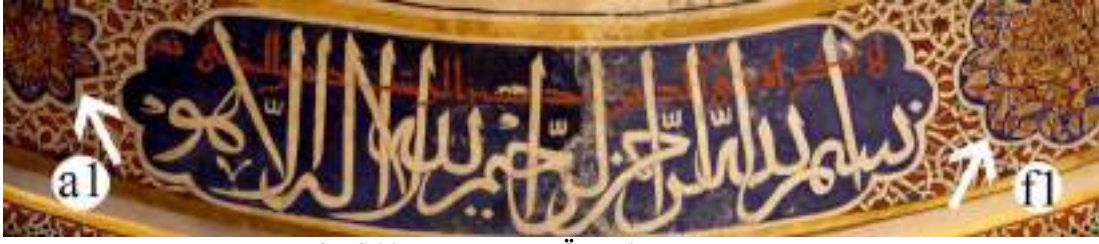
Resim 266: Restorasyon Öncesi, Kubbe Kasnağı
