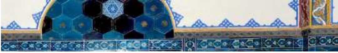
Resim 219: Güneybatı Cephe 2. Kademe (a8), 2019 (KAMACI, Ayşegül)
