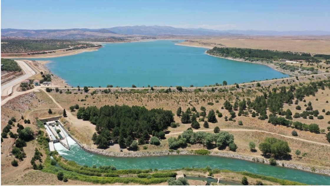
Şekil 2.7. Apa Barajı (DSİ, 2021)
