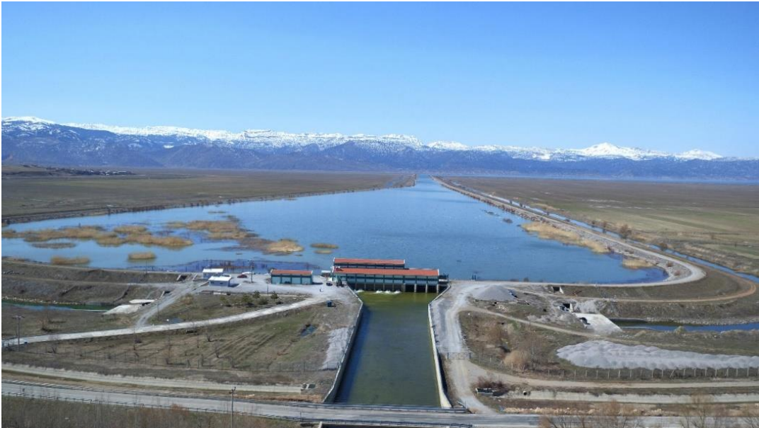
Şekil 2.10. Suęla Depolaması (DSİ, 2021)
