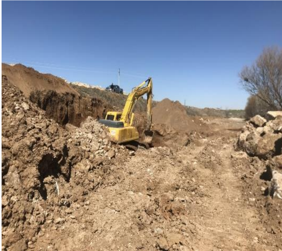
Şekil 4.22. Obruk kapatma çalışmaları
