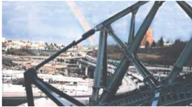
Şekil 3.13. Çelik kafes sisteme viskoz akışkanlı sönümleyici uygulaması (Aldemir, 2005)
