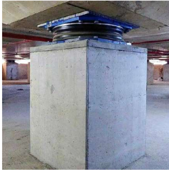
Şekil 3.5. Kolon altı sönümleyici-2 (URL-02)
