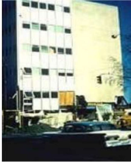
Şekil 3.17. Cordova Binasının genel görünümü (D1 Sarno ve Elnashai, 2002)
