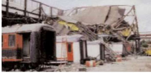
Şekil 3.22. Adapazarı vagon fabrikasında meydana gelen deprem hasarı (Kaltakçı ve ark., 2007)
