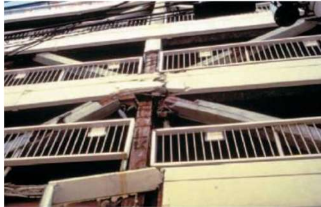
Şekil 3.21. EERI tarafından 1995 Kobe depreminde çelik çaprazlı bir çelik yapıda oluşan hasar (Tremblay ve ark. 1996)
