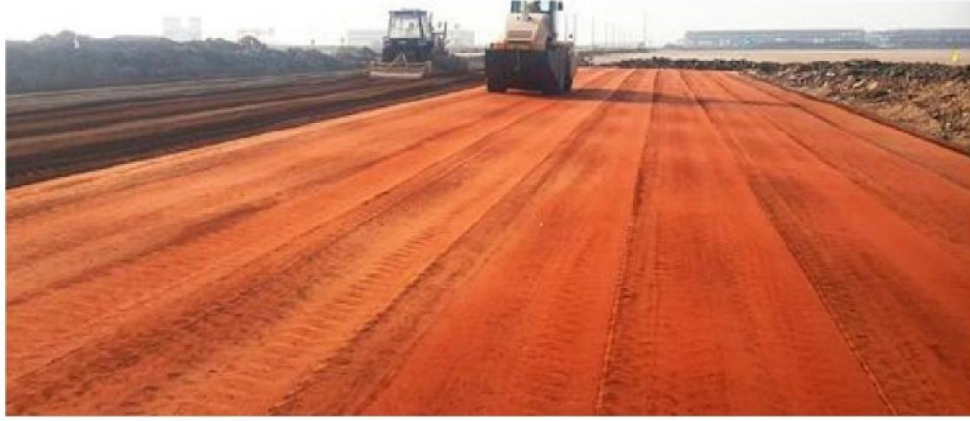
Şekil 2.6. Zibo şehrinde kırmızı çamurun yol alttemel malzemesi olarak kullanımı
