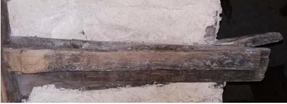
Resim 62 Kapı Kilit Sistemi ( Ksk)
