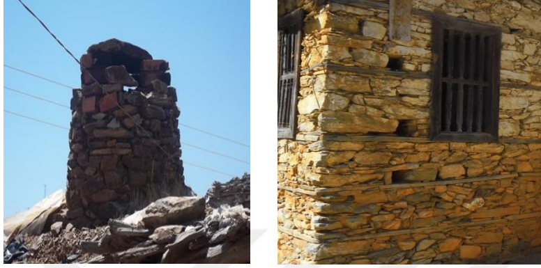
Resim 18-19 Baca ve Kuru Duvar Örgüsü
