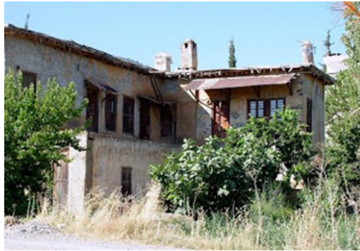
Resim 38 Hüseyin Özaltun Evi Sofaya Dış Açılan Oda Kapıları
