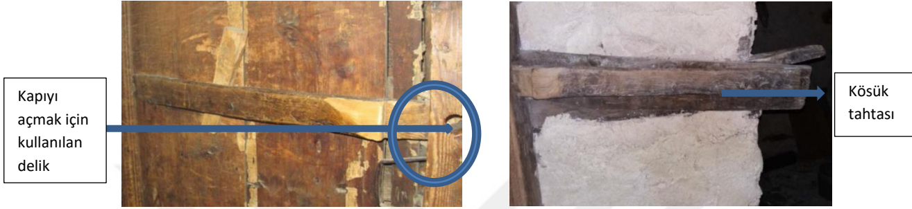
Resim 8 Kilit Sistemi (Kösük) Örnekleri
