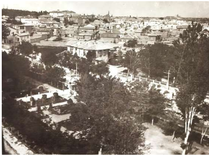
Şekil 6.63. Amber Reis Camii minaresinden kente bakış, sol altta Konya Lisesi bahçesi, karşısında Millet Bahçesi, tarih bilinmiyor (Odabaşı, Özönder ve Karpuz, 2000)
