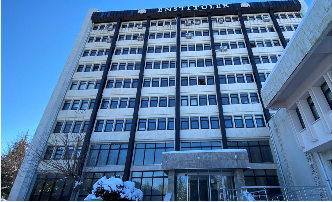
Şekil 5.19. S.Ü. Enstitüler binası kuzey doğu cephe görüntüsü
