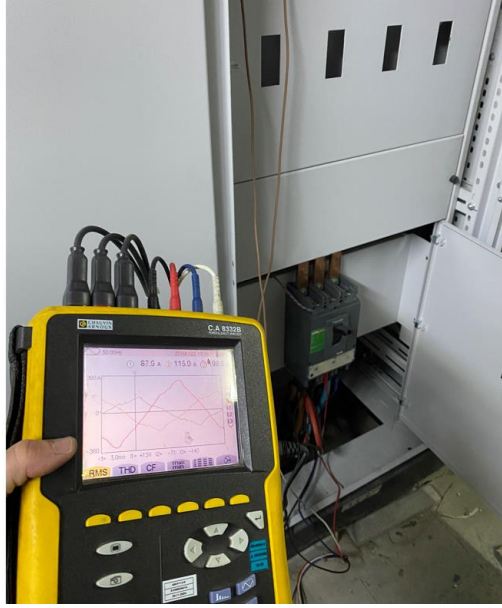
Şekil 5.54. Ana dağıtım panosu enerji analizörü ölçüm görüntüsü
