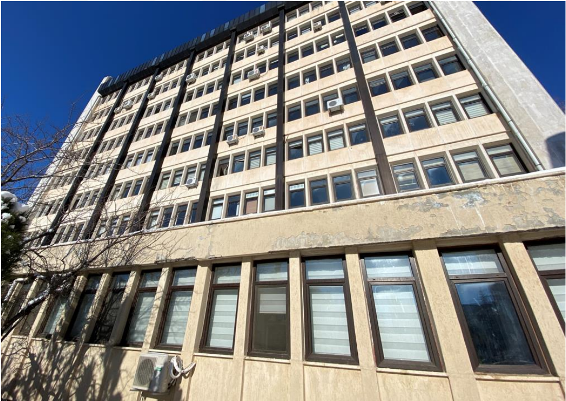
Şekil 5.20. S.Ü. Enstitüler binası güney batı cephe görüntüsü
