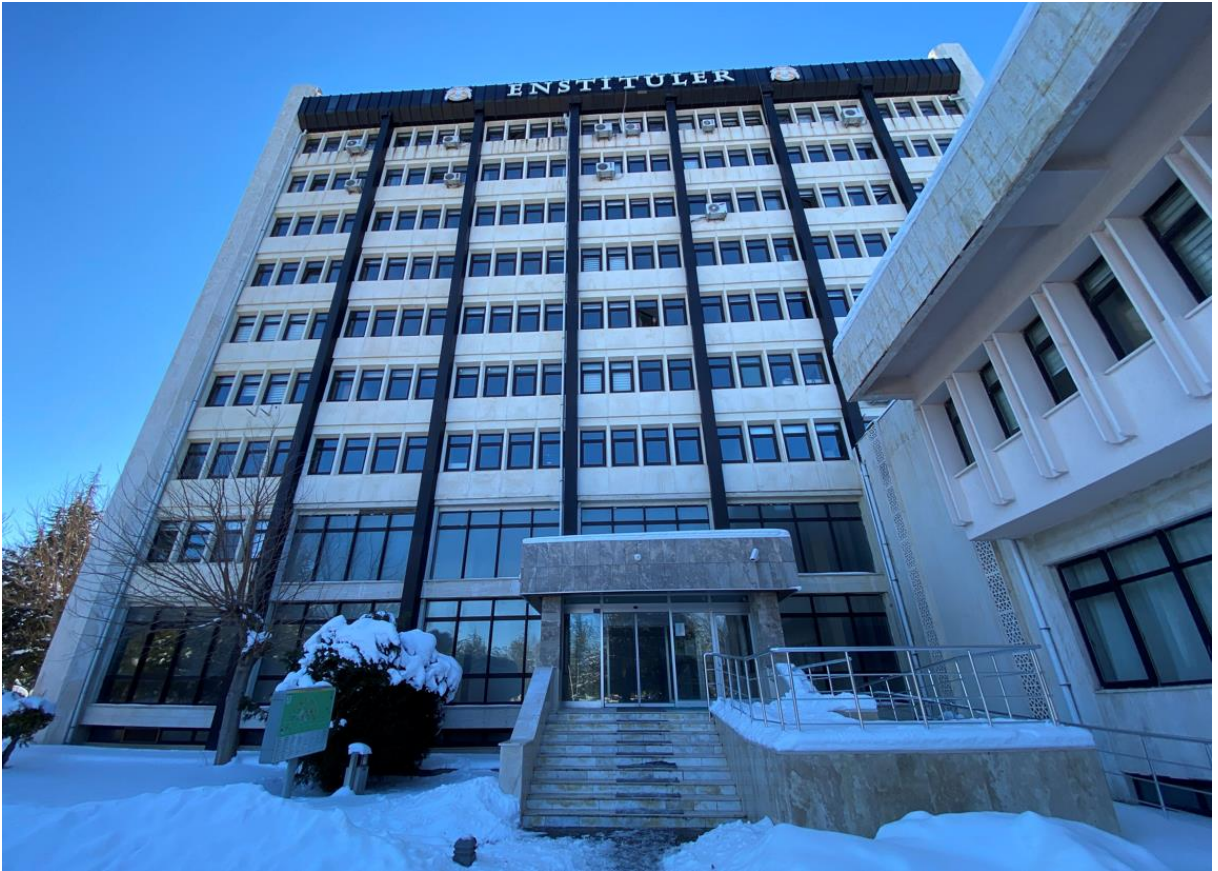
Şekil 5.16. S.Ü. Enstitüler binası genel görünüm (27.01.2022)
