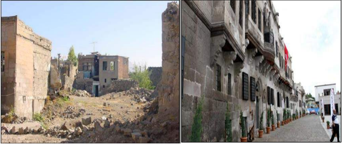
Şekil 4. 50. Kayseri kentsel sit alanında harabe durumundaki yapılar (Yılmaz, 2005 ve Orijinal, 2019)
