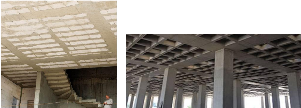
Şekil 3.6. Dişli döşeme örnekleri
