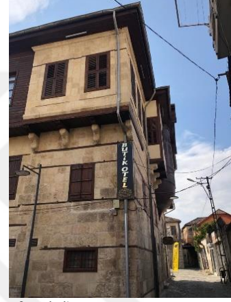
Şekil 2.30. Yığma sistem (Topbaş, 2021 Fotoğraf arşivi).
