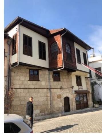
Şekil 2.31. Karma sistem (Topbaş, 2021 Fotoğraf arşivi).
