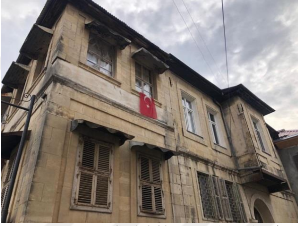
Şekil 2.30. Yığma sistem (Topbaş, 2021 Fotoğraf arşivi).
