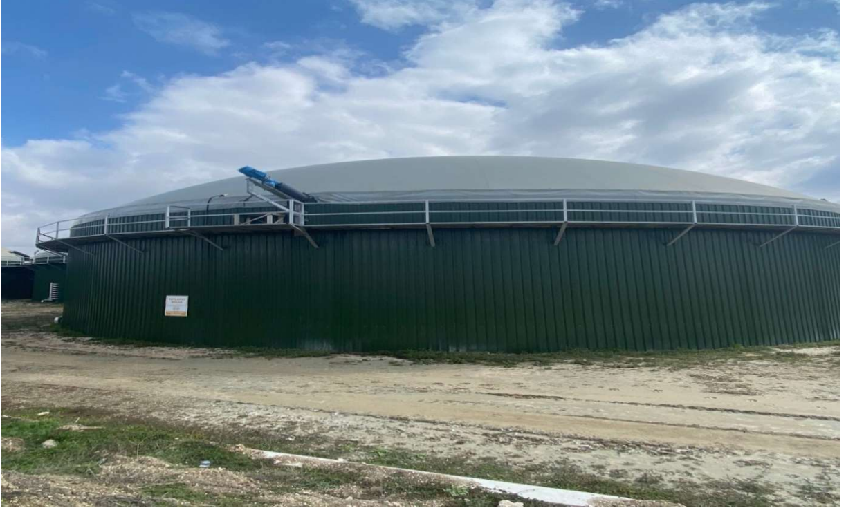
Şekil 3.5. Atık ve gaz depolama reaktörü
