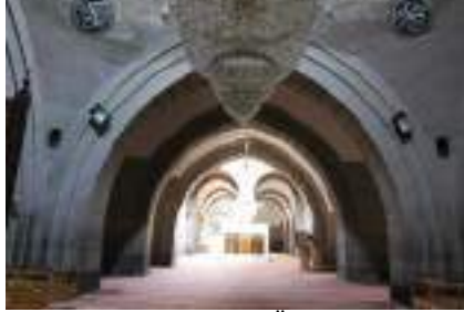
Fot. 9. Kayseri Hunad Camii (Özbek ve Arslan 2008)
