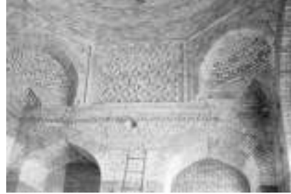
Fot. 12. Karahanlılar Döneminde Talhatan Baba Cami kubbeye geçiş elemanı (Web iletisi 6)
