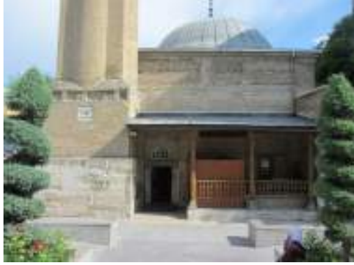
Fot. 28. Hoca Hasan Mescidi kuzey cephesi
