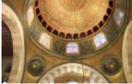
Fot. 7. Mescid-ül Aksa'nın kubbeye geçiş elemanı
