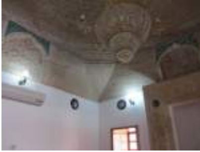
Fot. 25. Kubbeye geçiş elemanı
