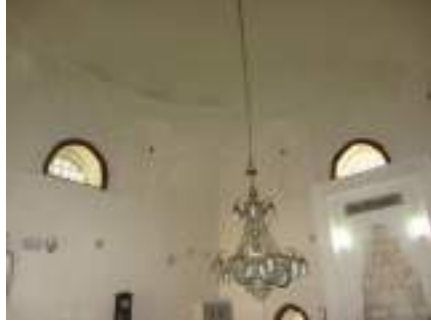
Fot. 30. Hoca Hasan Mescidi kubbeye geçiş elemanı
