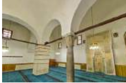
Fot. 8. Tokat Garipler Camii ayaklar üzerindeki pandantif kubbeye geçiş elemanı (Web iletisi 4)
