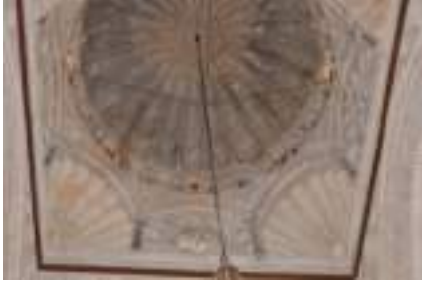
Fot. 11. Kayravan Camii kubbeye geçiş elemanı (Web iletisi 5)
