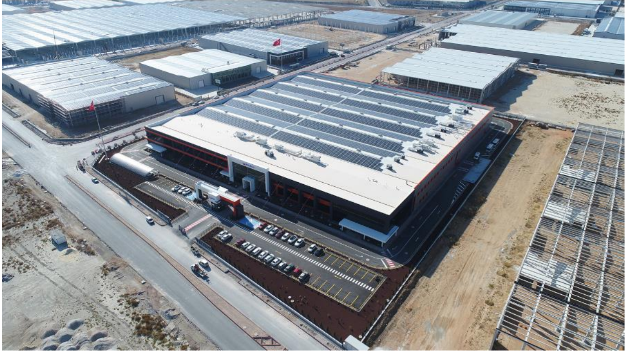
Şekil 3.1. Fabrikanın çatısındaki güneş paneli projesi Drone tarafından elde edildi.
