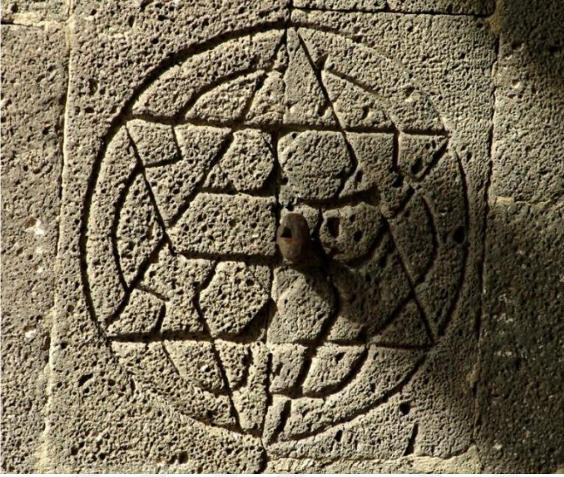
Fotoğraf 99: Diyarbakır Mesudiye Medresesi Batı Revaktaki Madalyon.
