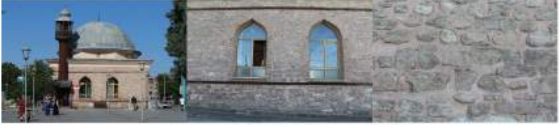
a. Ak Camii genel görünümü ve duvar örgü malzemesi
