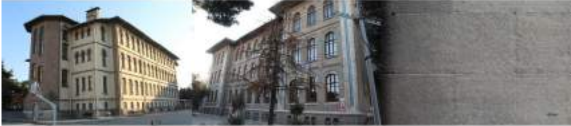
b. Konya Lisesi genel görünümü ve duvar örgü malzemesi
