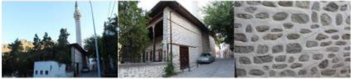
c. Sille Ak Camii genel görünümü ve duvar örgü malzemesi
