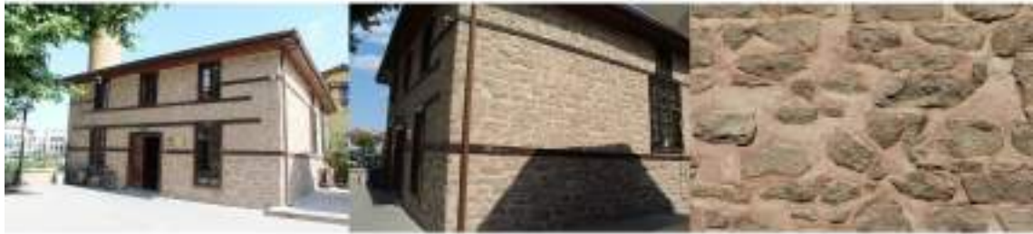
c. Kadı Mürsel Mescidi genel görünümü ve duvar örgü malzemesi
