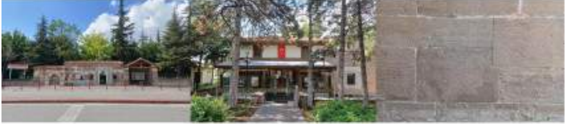
b. Hoca Ahmed Fakih Camii genel görünümü ve duvar örgü malzemesi
