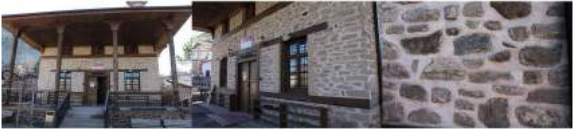
a. Sille Subaşı Camii genel görünümü ve duvar örgü malzemesi
