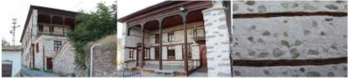
b. Mezaryaka Camii genel görünümü ve duvar örgü malzemesi
