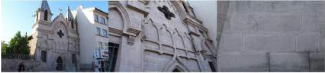
a. Aziz Pavlus Katolik Kilisesi genel görünümü ve duvar örgü malzemesi
