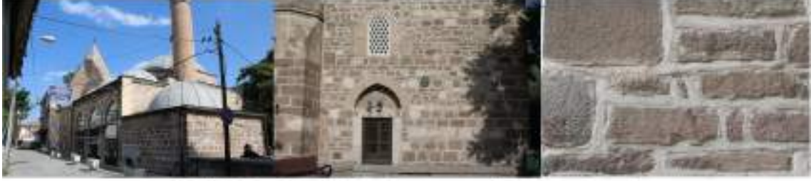
b. Piri Mehmet Paşa Camii genel görünümü ve duvar örgü malzemesi
