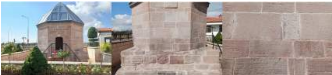
a. Ateşbaz Veli Türbesi genel görünümü ve duvar örgü malzemesi
