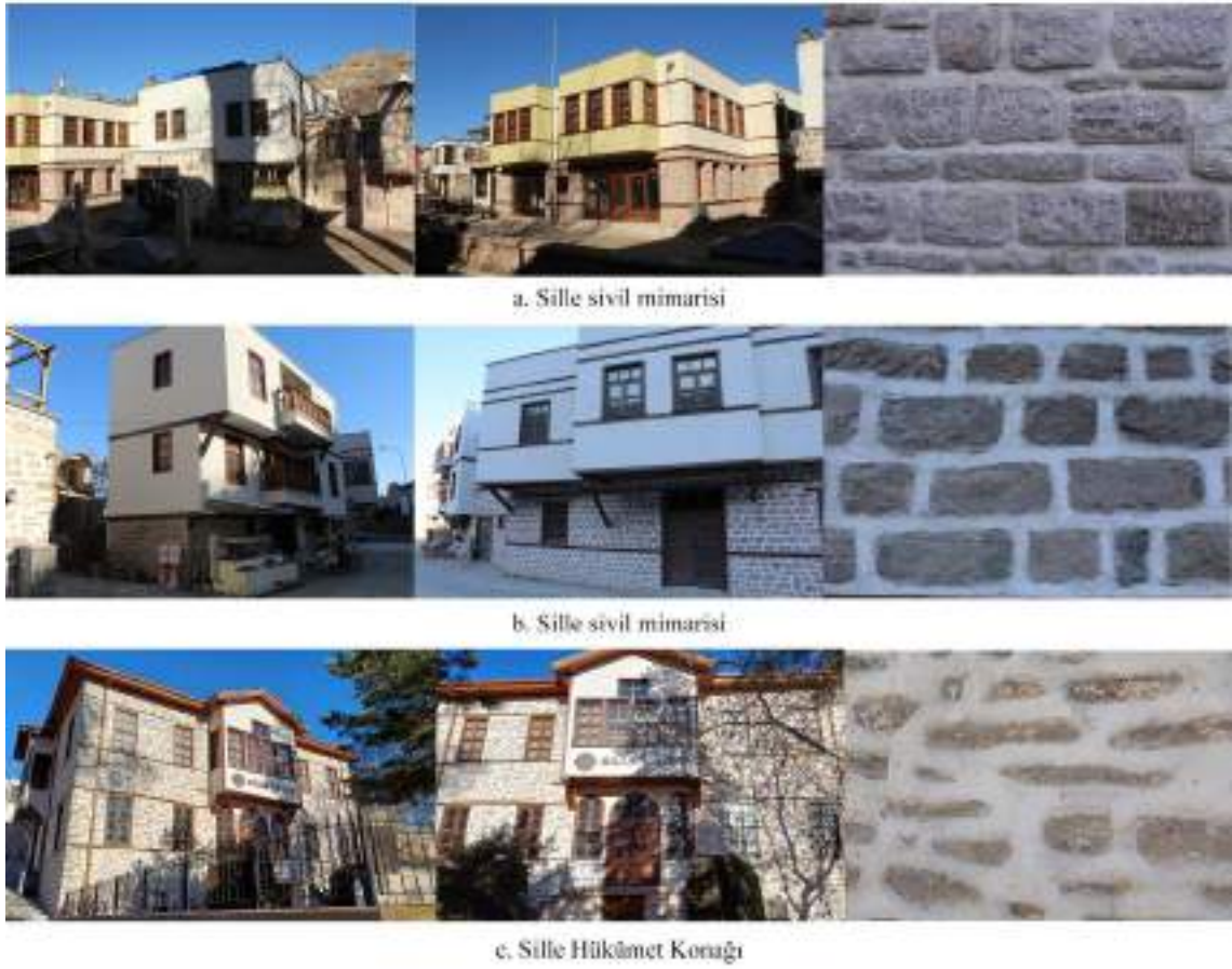
Şekil 2.7. Sille andezitik tüflerinin restorasyon – rekonstrüksiyon faaliyetlerinde kullanımı (Ş.S. Gürel Kişisel Arşivi, 2025)
