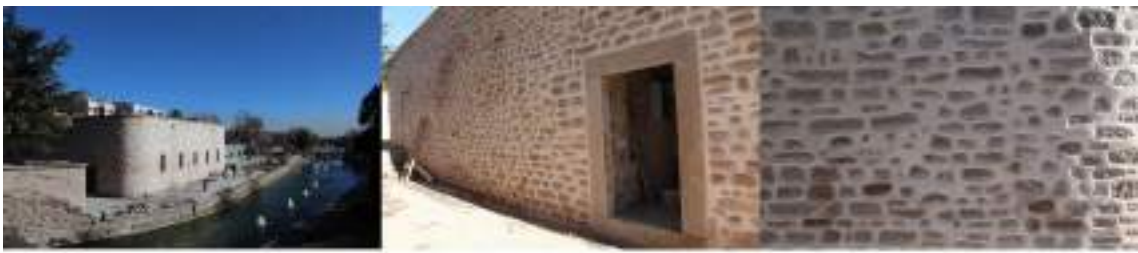
a. Hacı Ali Ağa Hamamı genel görünümü ve duvar örgü malzemesi
