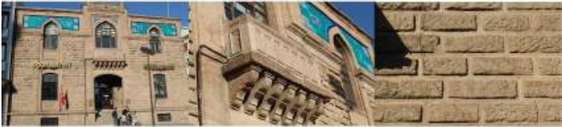
c. Yapı Kredi Bankası binası genel görünümü ve duvar örgü malzemesi
