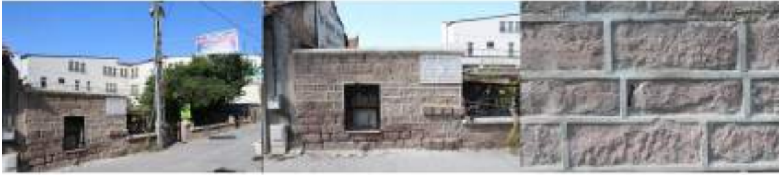
c. Piri Mehmet Paşa zaviyesi genel görünümü ve duvar örgü malzemesi
