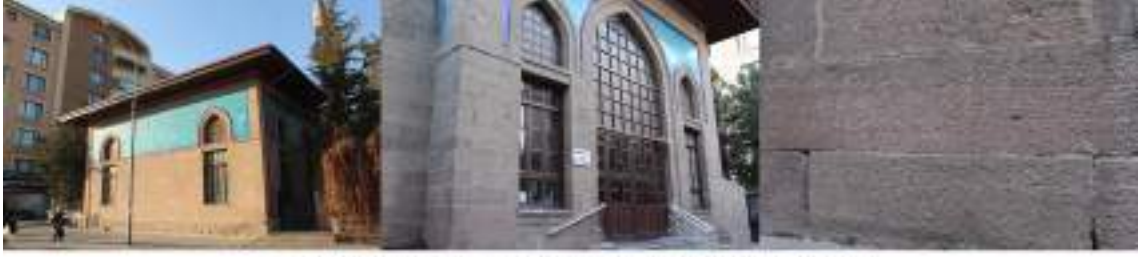
a. Amber Reis Camii genel görünümü ve duvar örgü malzemesi
