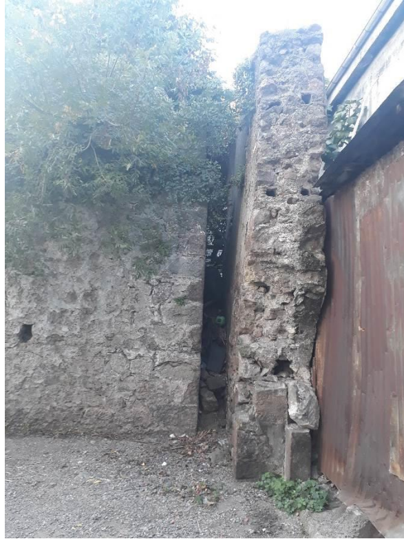
Fotoğraf 99: Hacı Arif Hamamı. Batı cephe.
