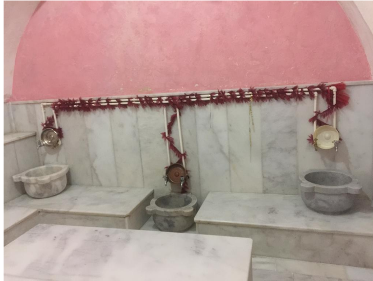
Fotoğraf 85: İskender Paşa Hamamı. Kadınlar bölümü, sıcaklık mekanlarından güneyde olan kısım, kurnalar ve duvar yüzeyleri.
