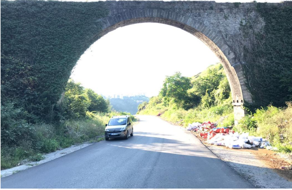
Fotoğraf 277: Kavaklı Su Kemerı. Duvar örgüsü (Kuzeyden bakış).
