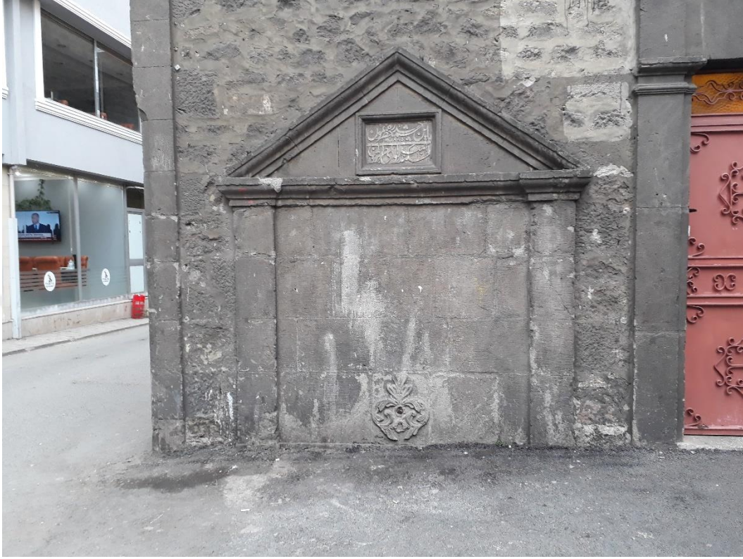
Fotoğraf 165: İskender Paşa Çeşmesi 3. Genel görünüş.
