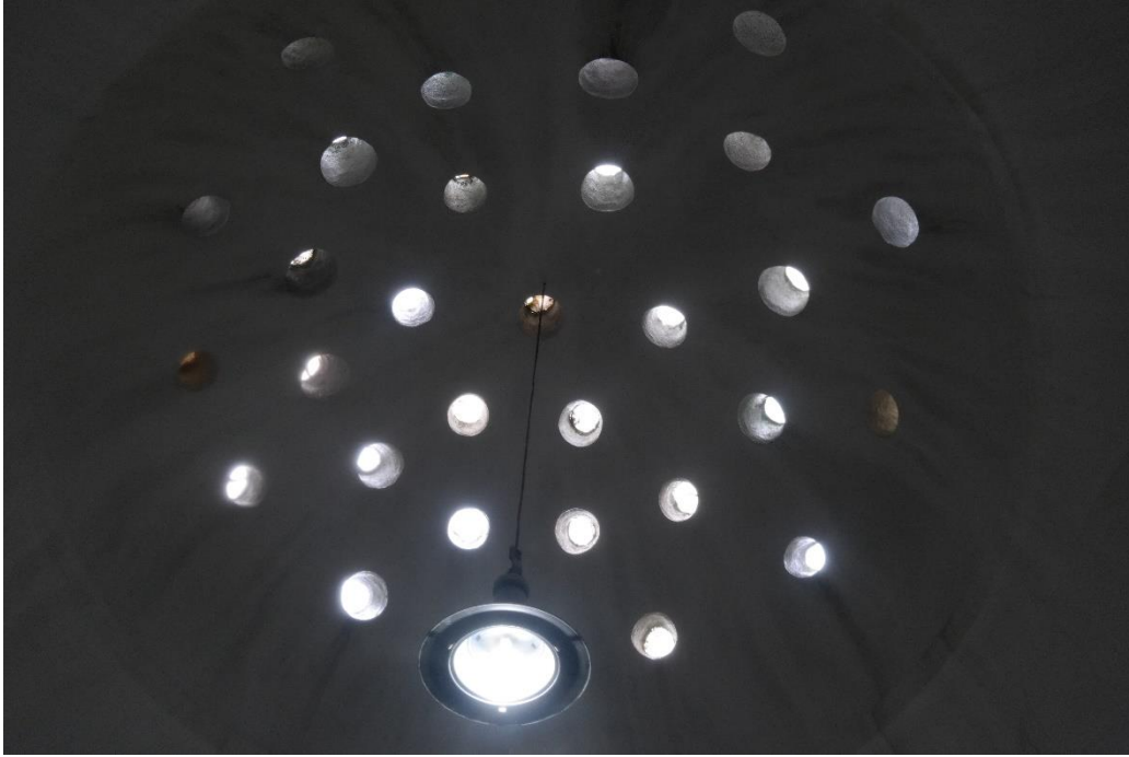
Fotoğraf 141: Meydan Hamamı. Erkekler bölümü sıcaklık, kubbelerde yer alan fil gözleri.
