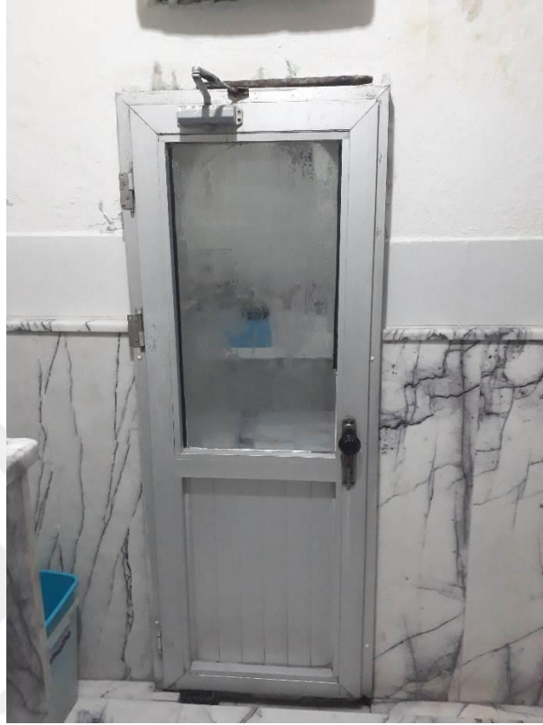
Fotoğraf 72: İskender Paşa Hamamı. Erkekler Sıcaklığa giriş.
