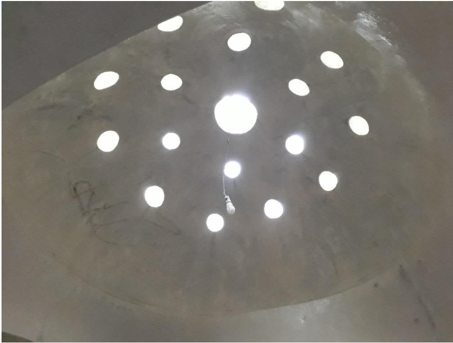
Fotoğraf 20: Fatih Hamamı. Sıcaklık, kubbede yer alan fil gözleri.
