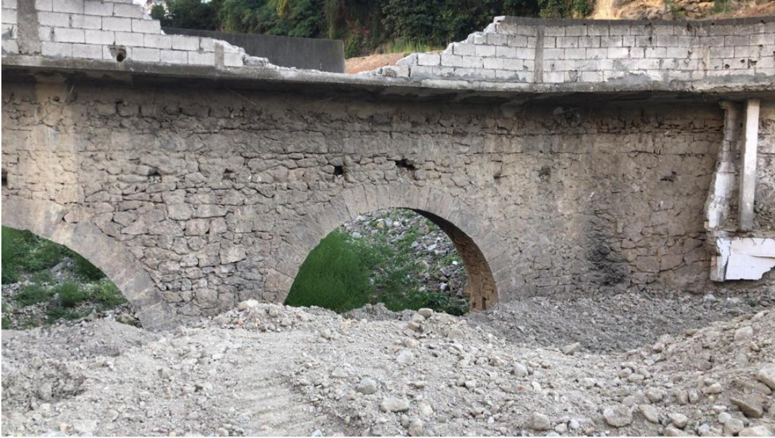
Fotoğraf 270: Kuzgundere Su Kemerini. Kuzey cephe, duvar rgs.
