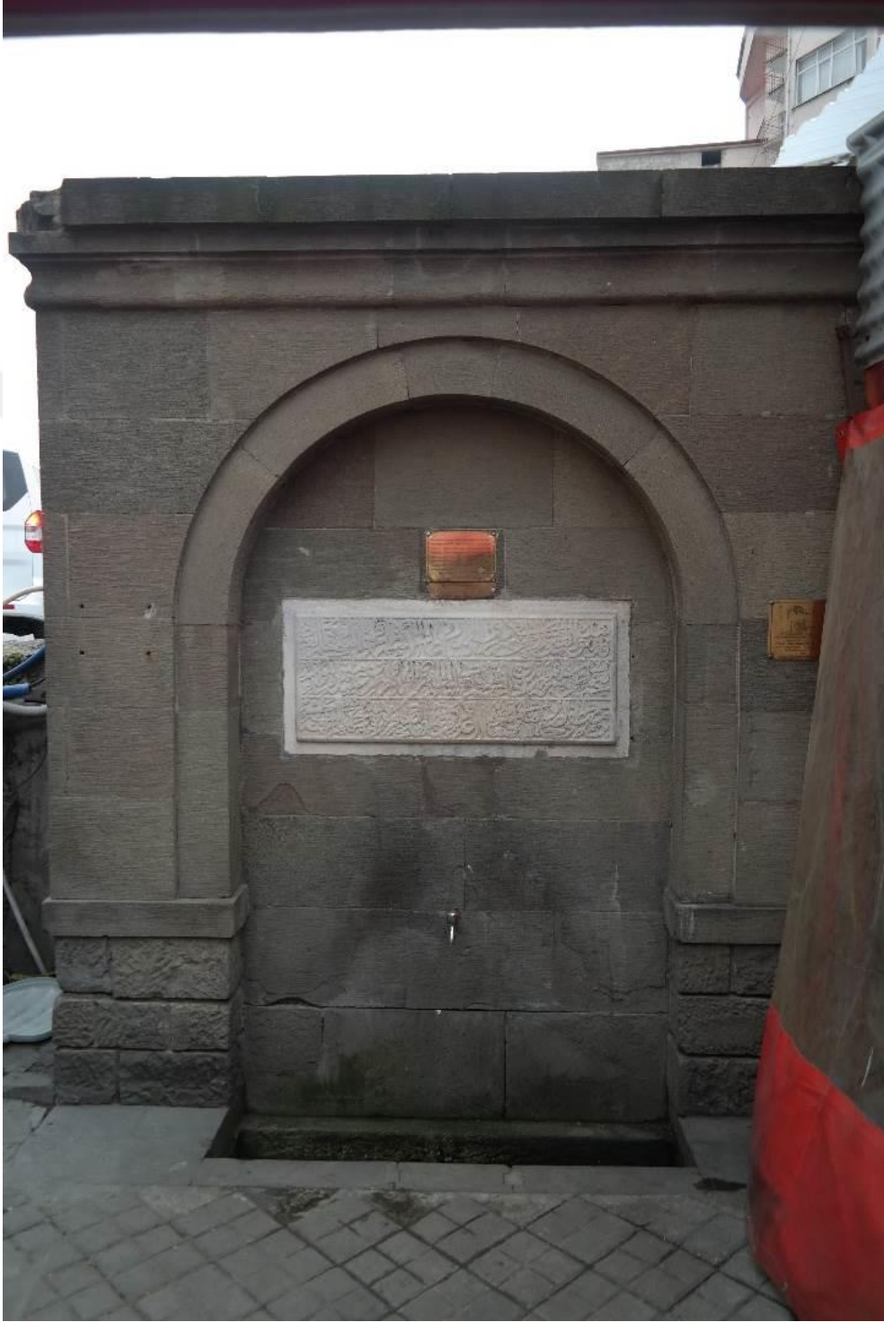
Fotoğraf 155: İskender Paşa Çeşmesi 1. Genel görünüş. 365
