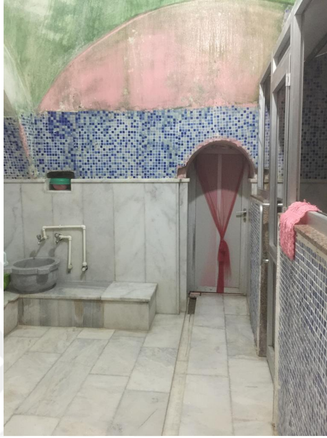
Fotoğraf 84: İskender Paşa Hamamı. Kadınlar bölümü, sıcaklık mekanlarından kuzeyde olan.
