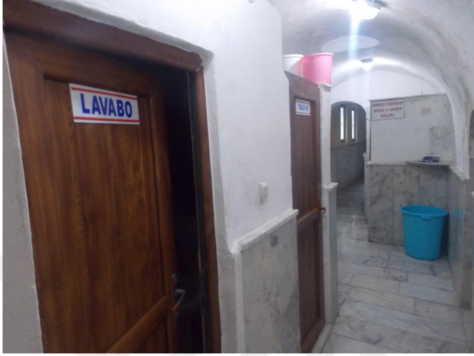
Fotoğraf 13: Fatih Hamamı. Soğukluk tuvalet, traşlık, Zemin, duvar yüzeyleri ve üst örtü genel görünüş.
