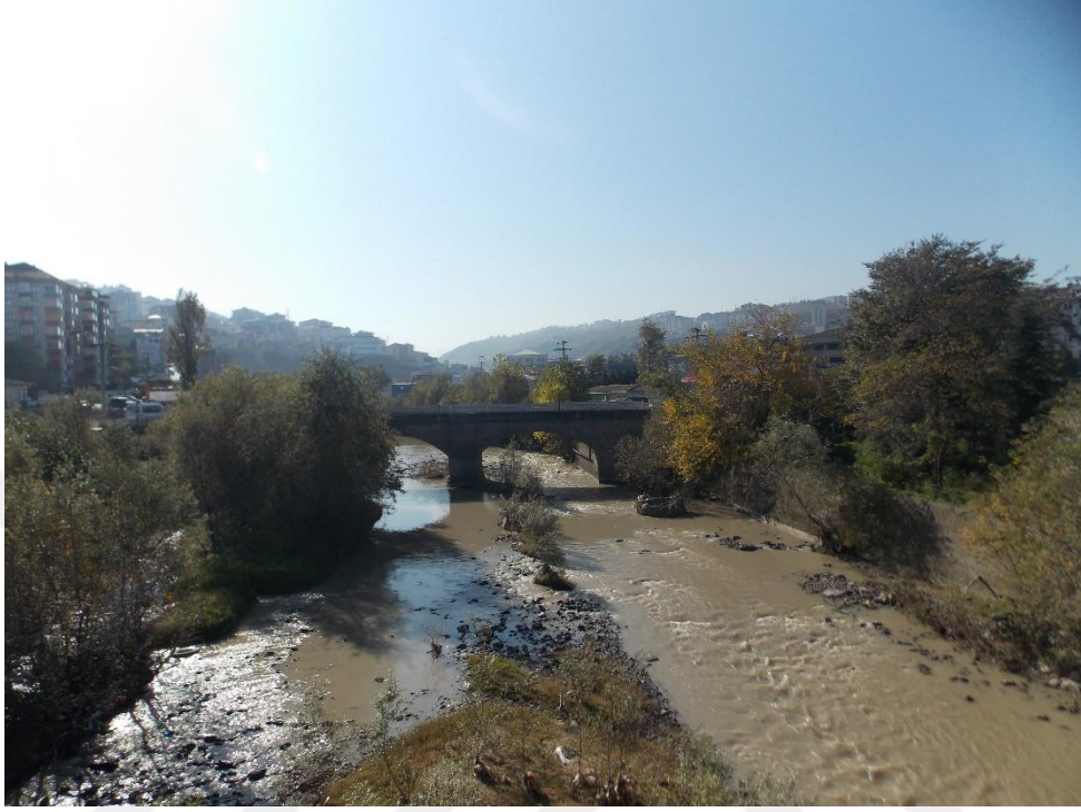
Fotoğraf 264: Değirmendere Köprüsü. Kuzey cephe genel görünüş.
