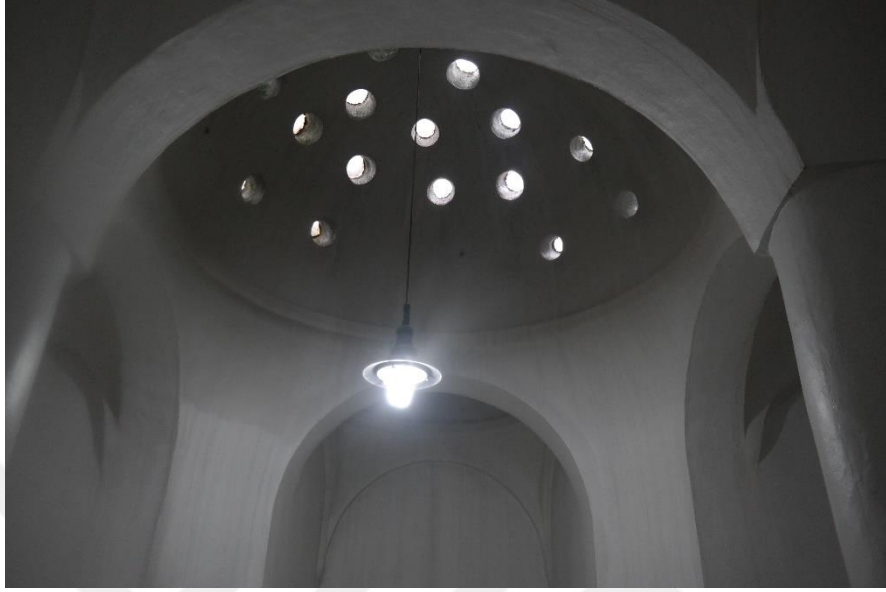
Fotoğraf 140: Meydan Hamamı. Erkekler bölümü sıcaklık, Kubbe geçişleri ve kemerler.
