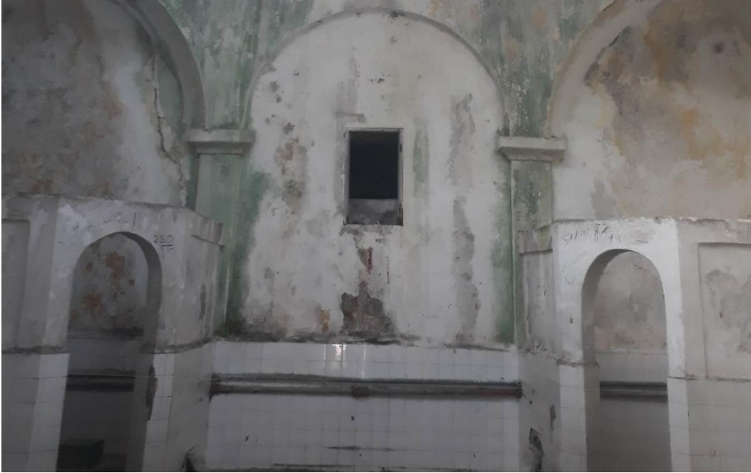
Fotoğraf 123: Askeri Hamam Sıcaklığın beti duvarında yer alan su kontrol penceresi.
