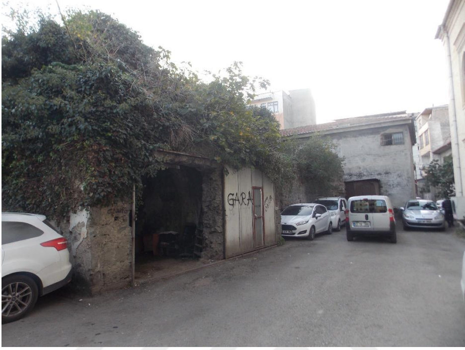
Fotoğraf 100: Hacı Arif Hamamı. Kuzey cephe.
