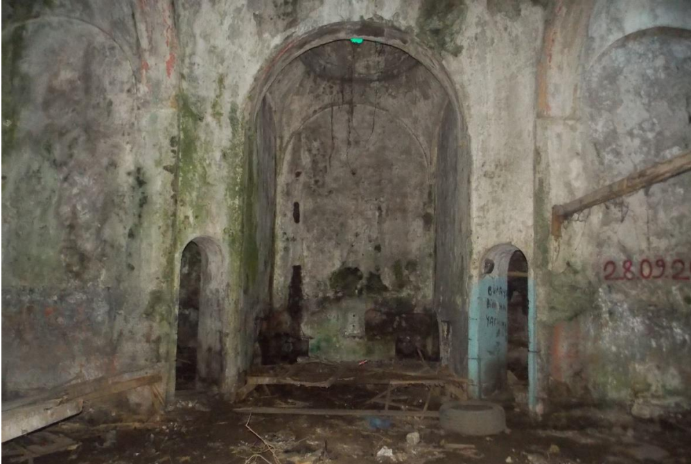
Fotoğraf 107: Hacı Arif Hamamı. Sıcaklık zemini, duvar yüzeyleri ve halvet hücreleri.
