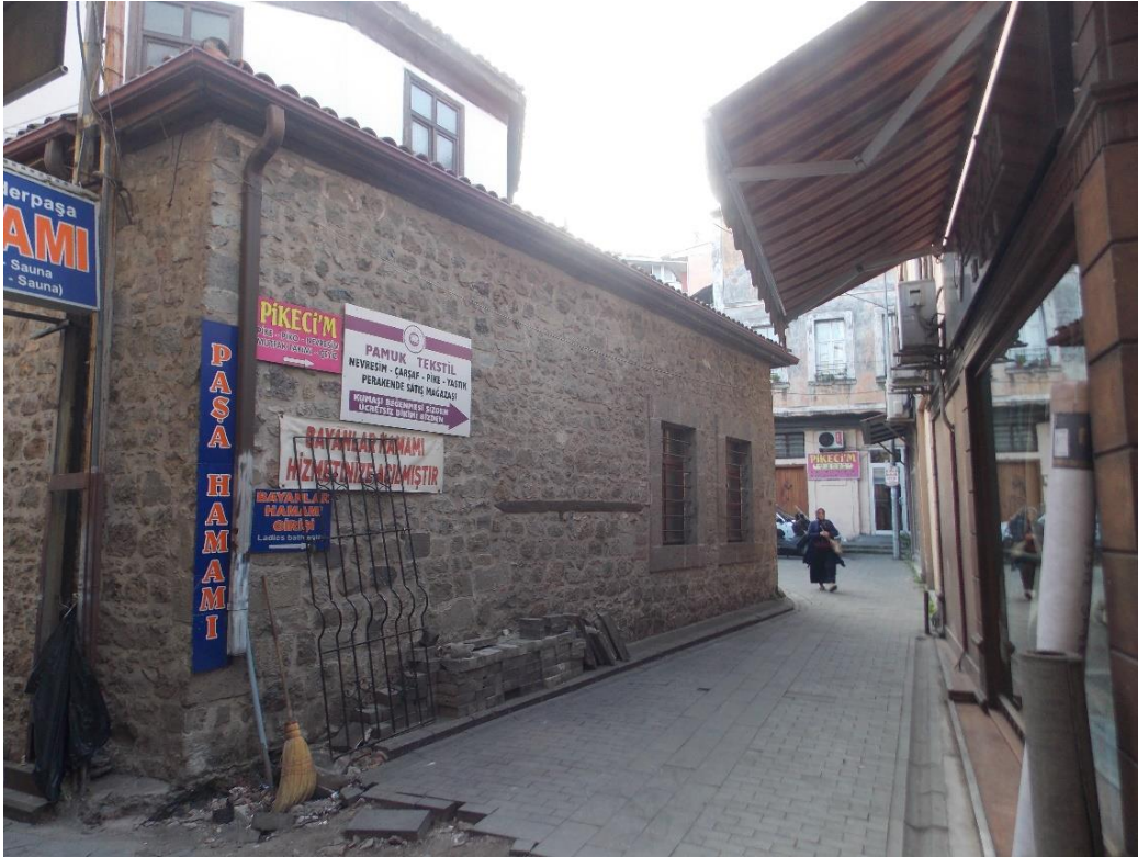
Fotoğraf 63: İskender Paşa Hamamı. Batı cephe genel görünüş.
