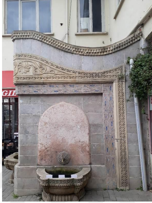
Fotoğraf 228: Anonim Çeşme 5. Cephe (Batı) görünüş.
