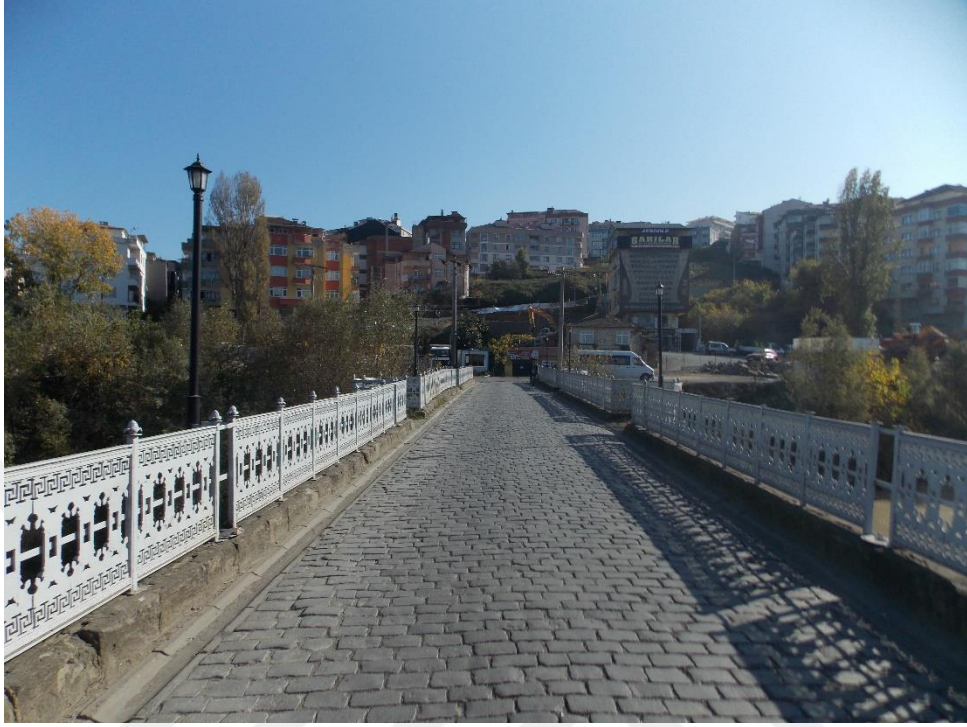
Fotoğraf 268: Değirmendere Köprüsü. Güney cephe menbalardan görünüş.
