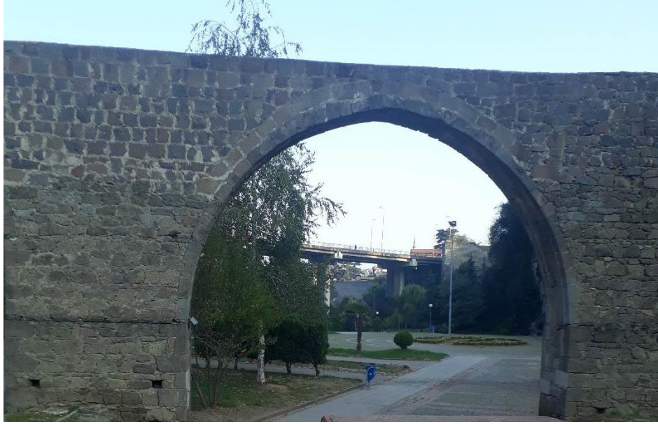
Fotoğraf 273: İmaret Su Kemerı. Orta da yer alan büyük kemer ve duvar örgüsü.
