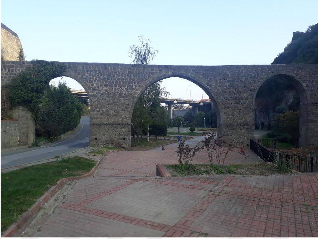
Fotoğraf 274: İmaret Su Kemerı. Güney cephe genel görünüş.
