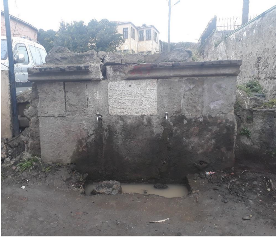
Fotoğraf 160: İskender Paşa Çeşmesi 2. Genel görünüş.
