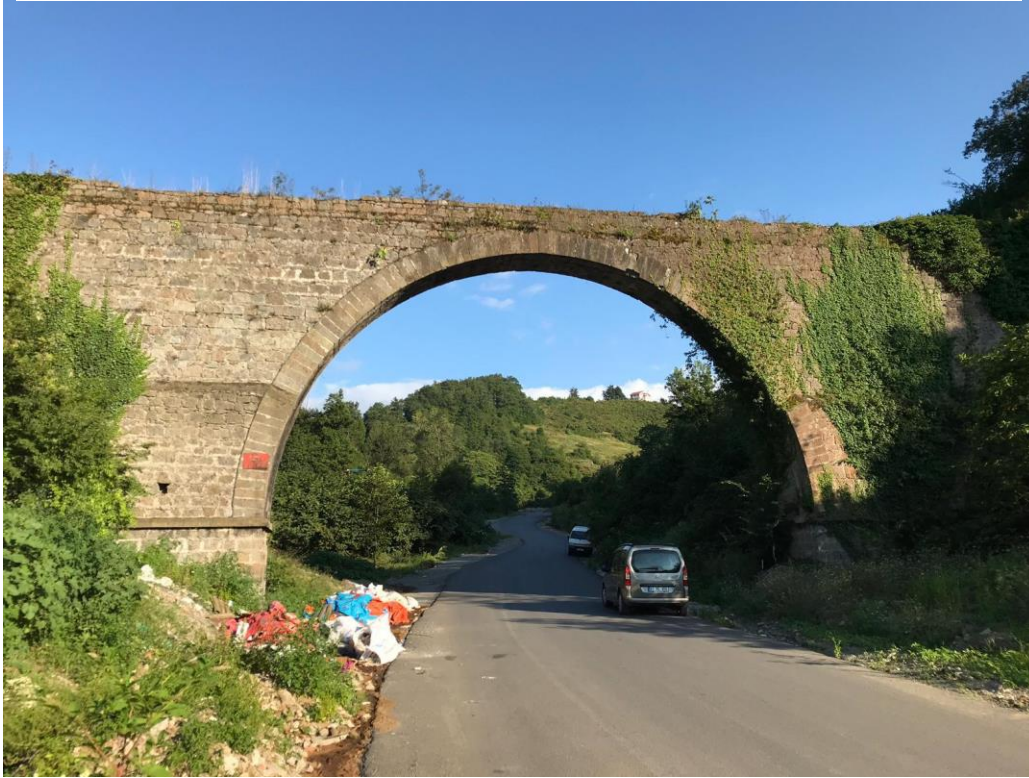
Fotoğraf 276: Kavaklı Su Kemerı. Güzey cephe genel görünüş.
