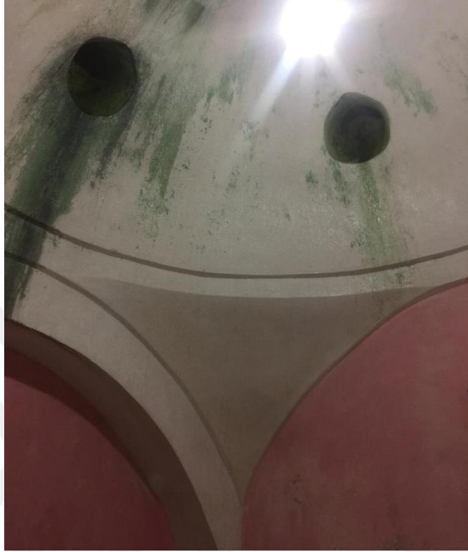
Fotoğraf 86: İskender Paşa Hamamı. Kadınlar bölümü, sıcaklık kubbe geçişleri ve fil gözleri.
