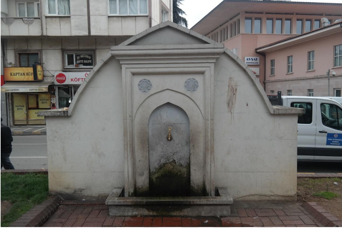
Fotoğraf 152: Seyyid Hacı Mehmed Çeşmesi. Güney cephesine yapılan çeşme.
