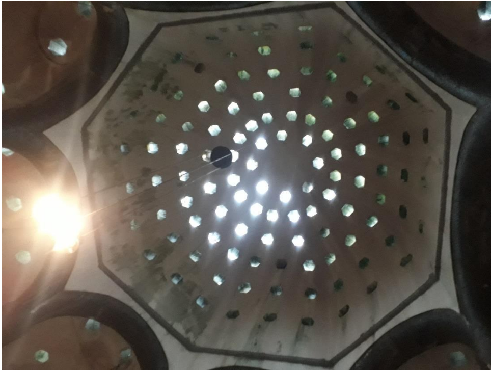
Fotoğraf 57: Sekiz Direkli Hamam. Sıcaklık kubbesi ve fil gözleri.
