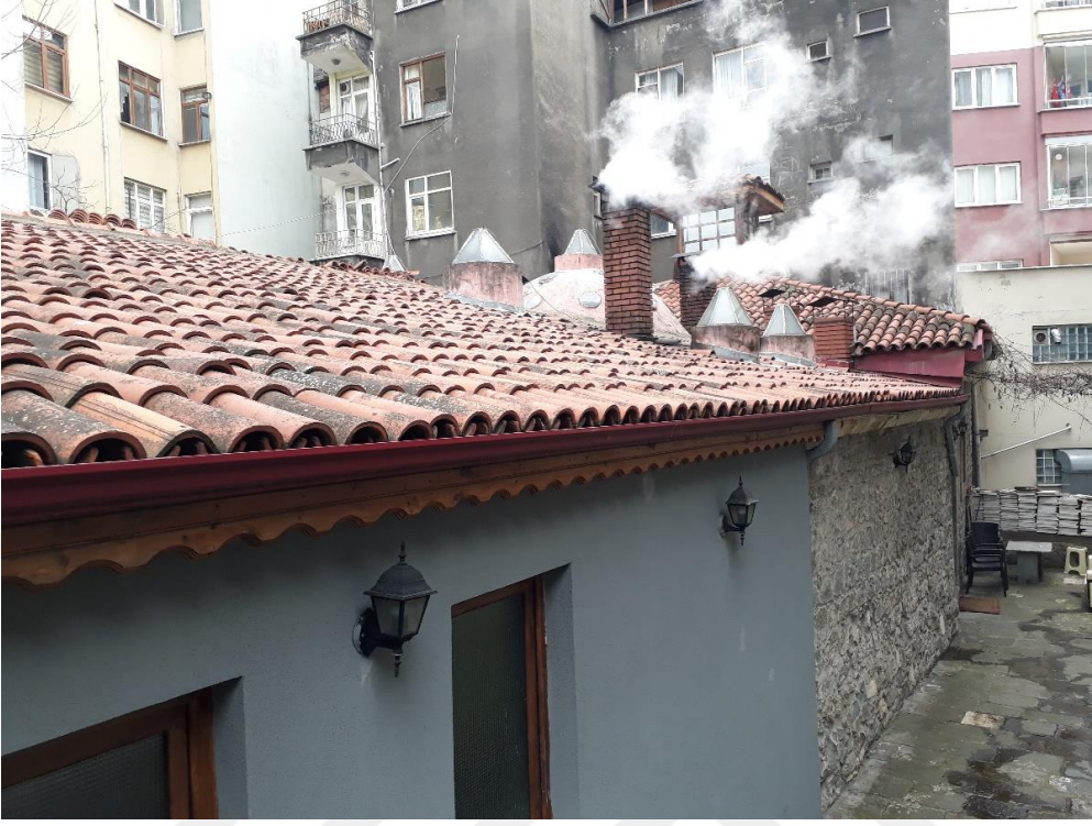
Fotoğraf 5: Fatih Hamamı. Kuzey cephe ve yapının üst örtüsünden genel görünüş.
