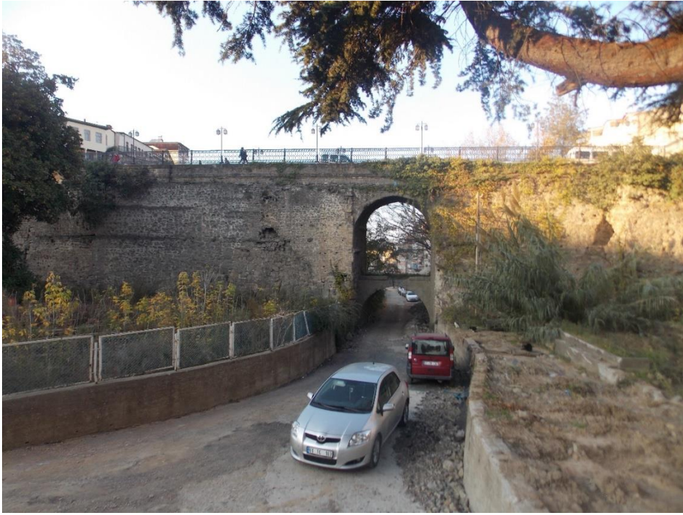
Fotoğraf 252: Tabakhane Köprüsü. Güney cephe genel görünüş.
