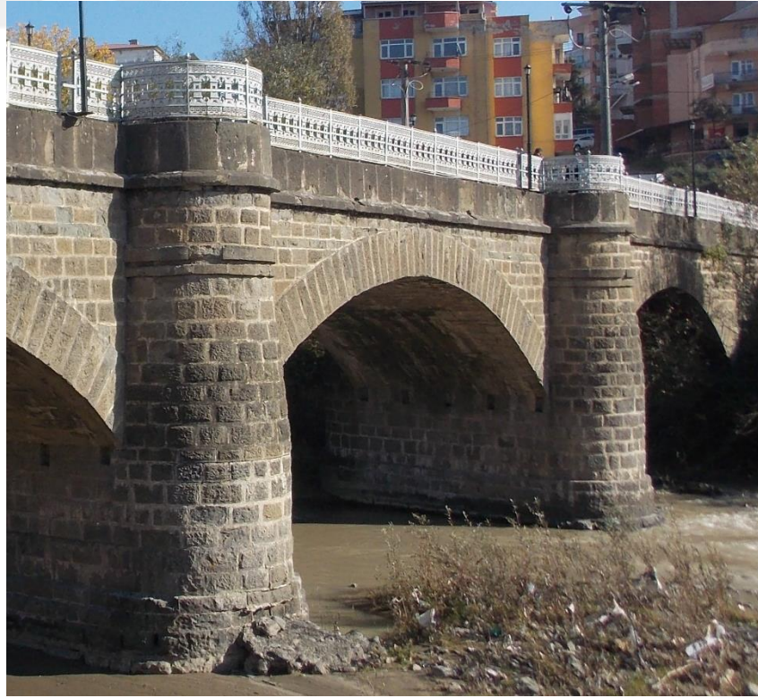
Fotoğraf 267: Değirmendere Köprüsü. Güney cephe selyaralardan görünüş.
