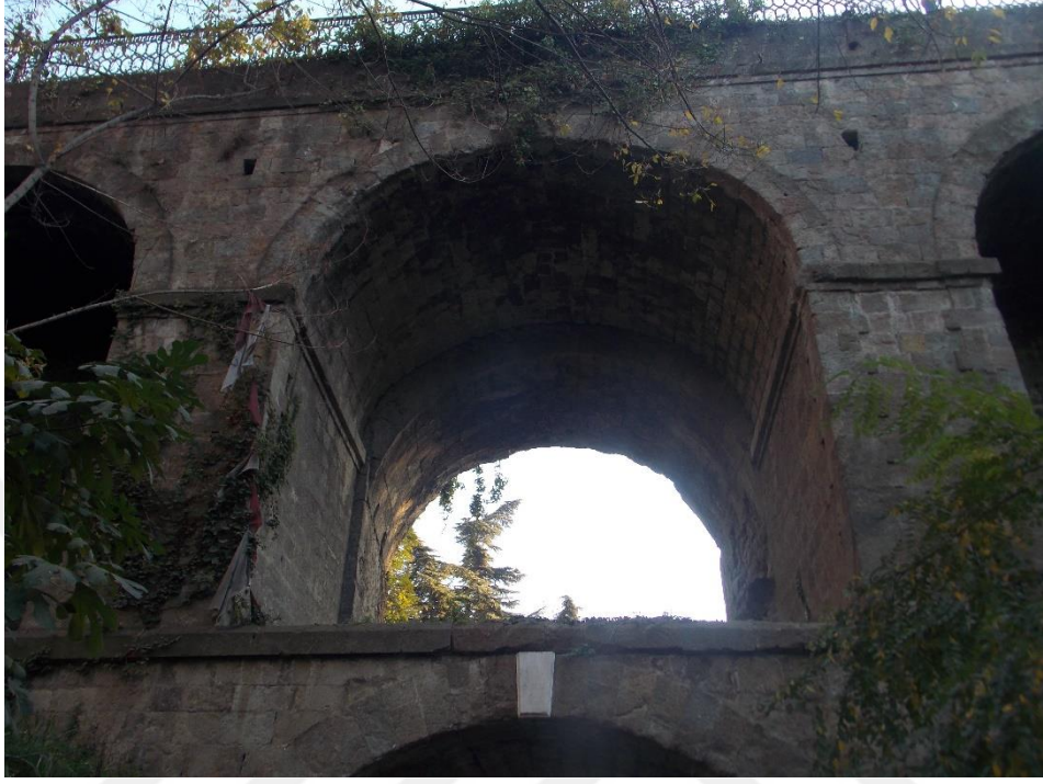
Fotoğraf 255: Tabakhane Köprüsü. Kuzey cephe kemer görünüş.
