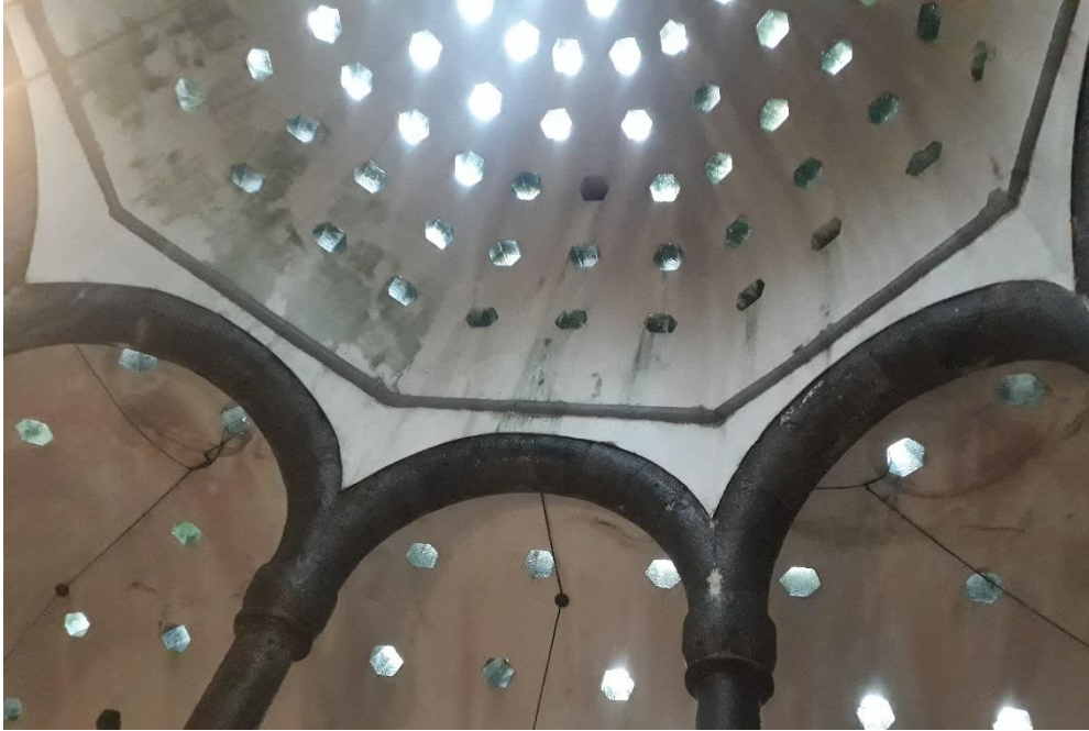
Fotoğraf 55: Sekiz Direkli Hamam. Sıcaklık kubesini taşıyan sütun ve kemerlerden görünüş.
