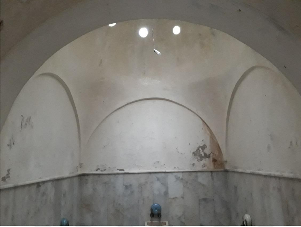
Fotoğraf 19: Fatih Hamamı. Sıcaklık, kubbe geçişleri ve yarım daire kemer.
