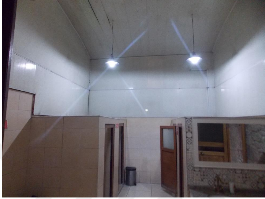
Fotoğraf 134: Meydan Hamamı. Erkekler bölümü aralığının kuzeyinde yer alan tuvalet ve traşlık.
