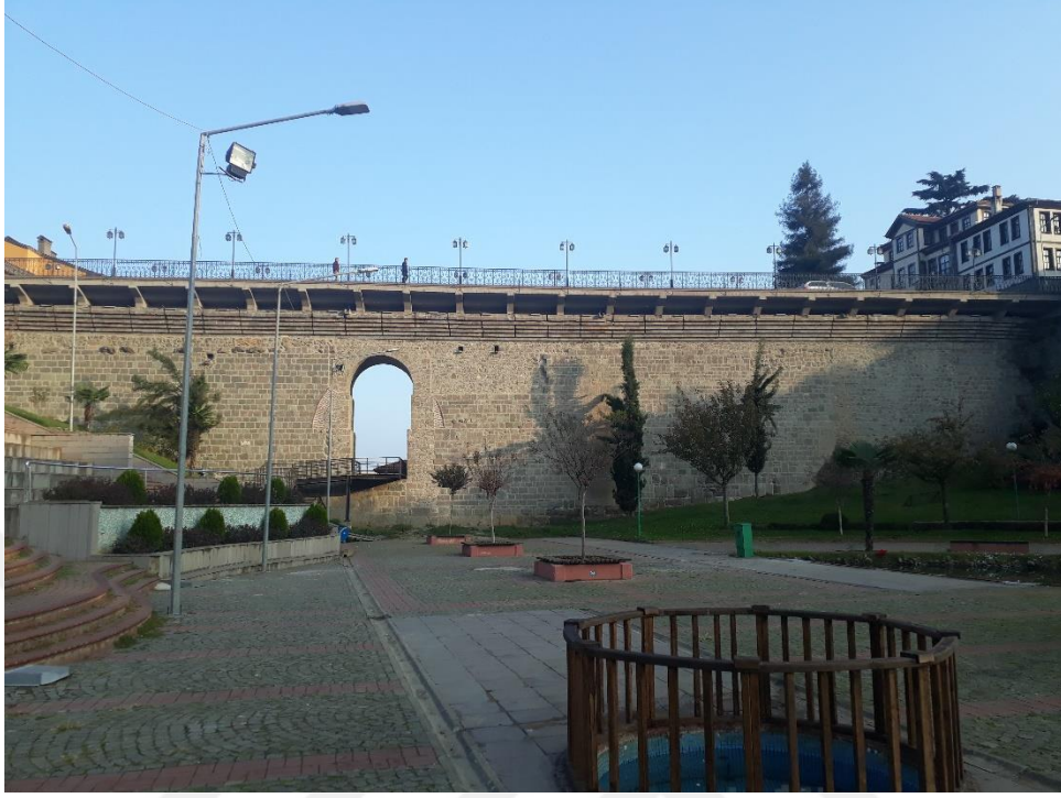
Fotoğraf 260: Zağnos Köprüsü. Güney cephe genel görünüş.
