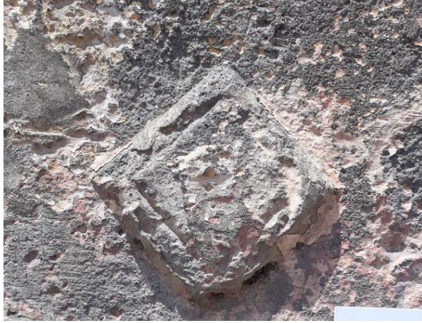
Fotoğraf 197: Çarıkçızade Hacı İsmail Çeşmesi. Lüle etrafındaki süsleme uygulaması.
