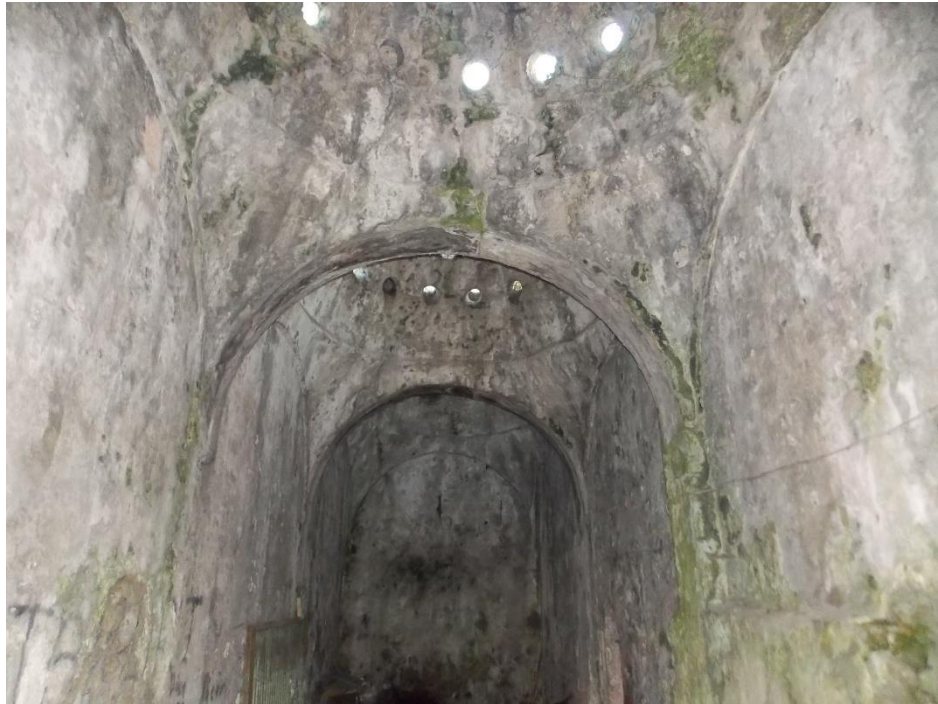
Fotoğraf 103: Hacı Arif Hamamı. Soğukluk, kubbe geçişleri ve kemerler.
