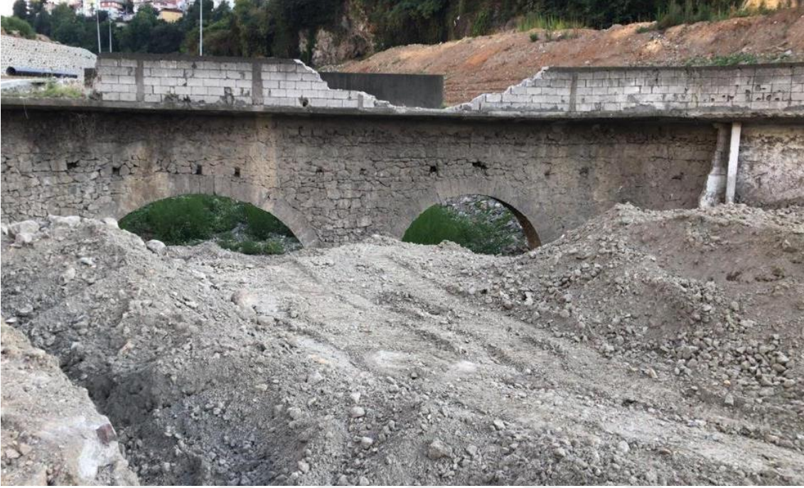
Fotoğraf 271: Kuzgundere Su Kemerli. Kemerler ve kanal kısmının yanlarına yapılan duvar örgüsü.
