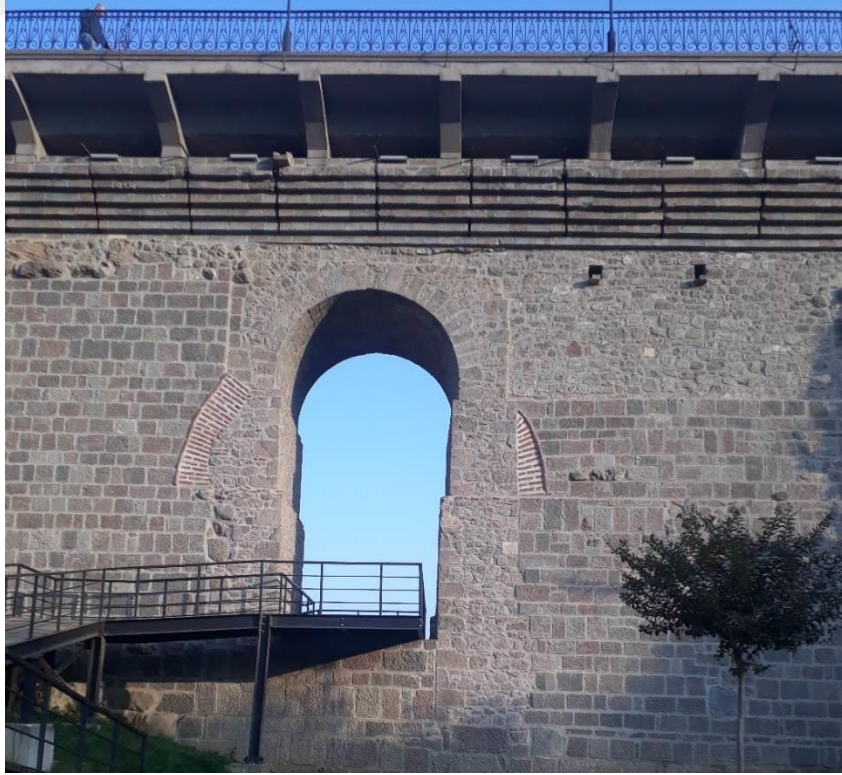
Fotoğraf 261: Zağnos Köprüsü. Kemer ve duvar örgüsü. (Güney cephe). 429
