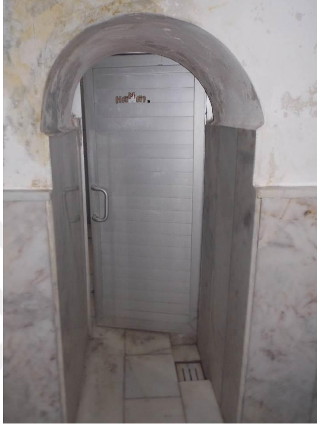
Fotoğraf 15: Fatih Hamamı. Sıcaklığa giriş.
