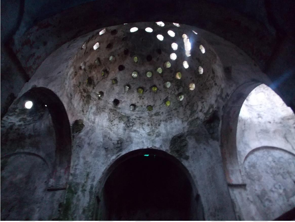
Fotoğraf 106: Hacı Arif Hamamı. Sıcaklık kubbesi, kubbe geçişleri, fil gözleri.
