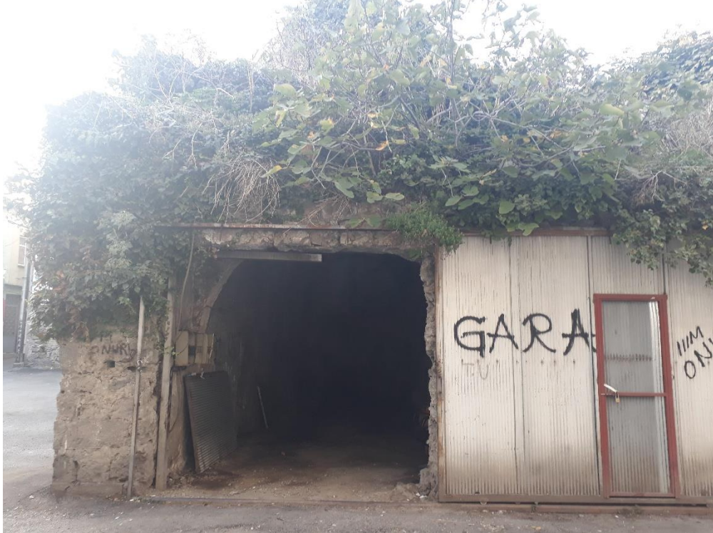
Fotoğraf 101: Hacı Arif Hamamı. Kuzey cephe, hamama girişı sađlayan aıklık.
