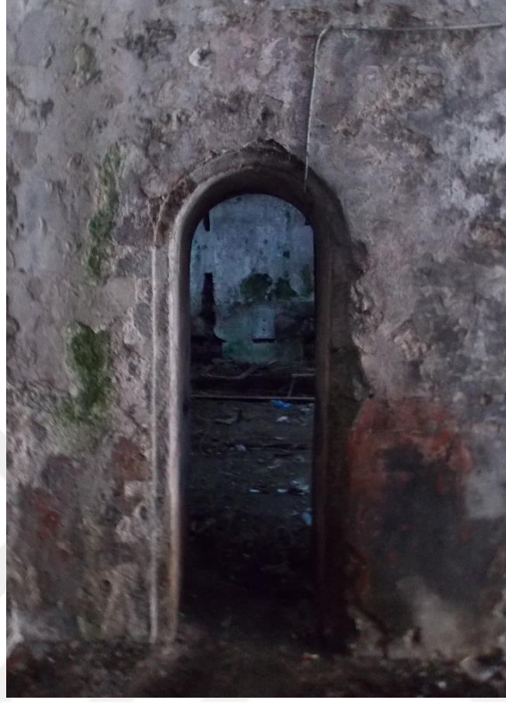
Fotoğraf 104: Hacı Arif Hamamı. Sıcaklığa giriş.
