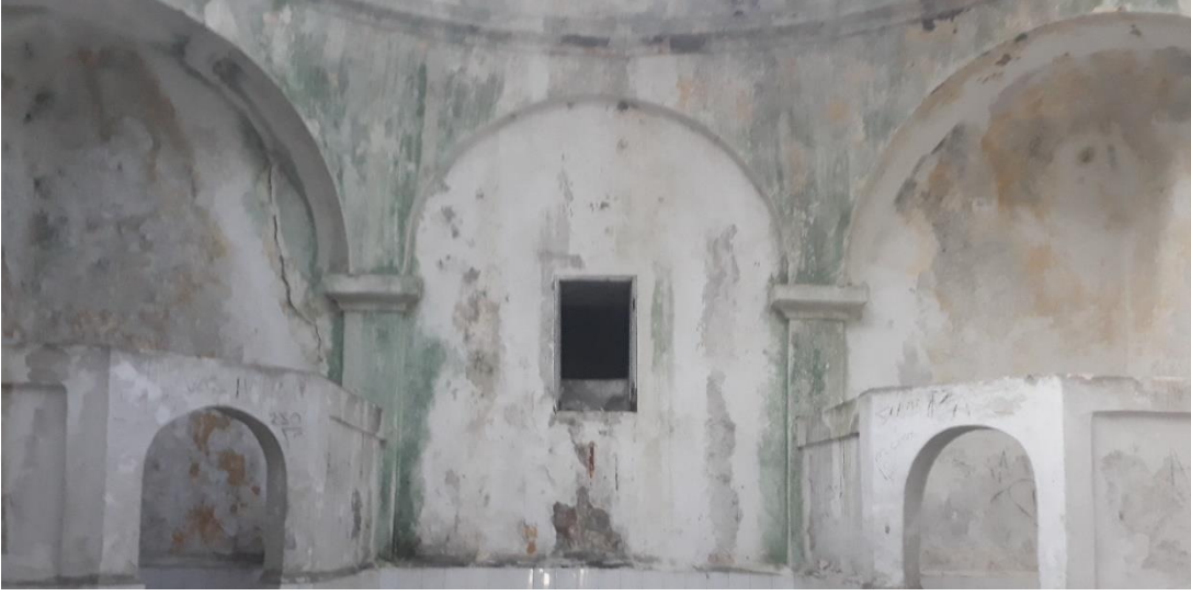
Fotoğraf 120: Askeri Hamam Sıcaklık, kubbe geçişleri, plasterler, kemerler.
