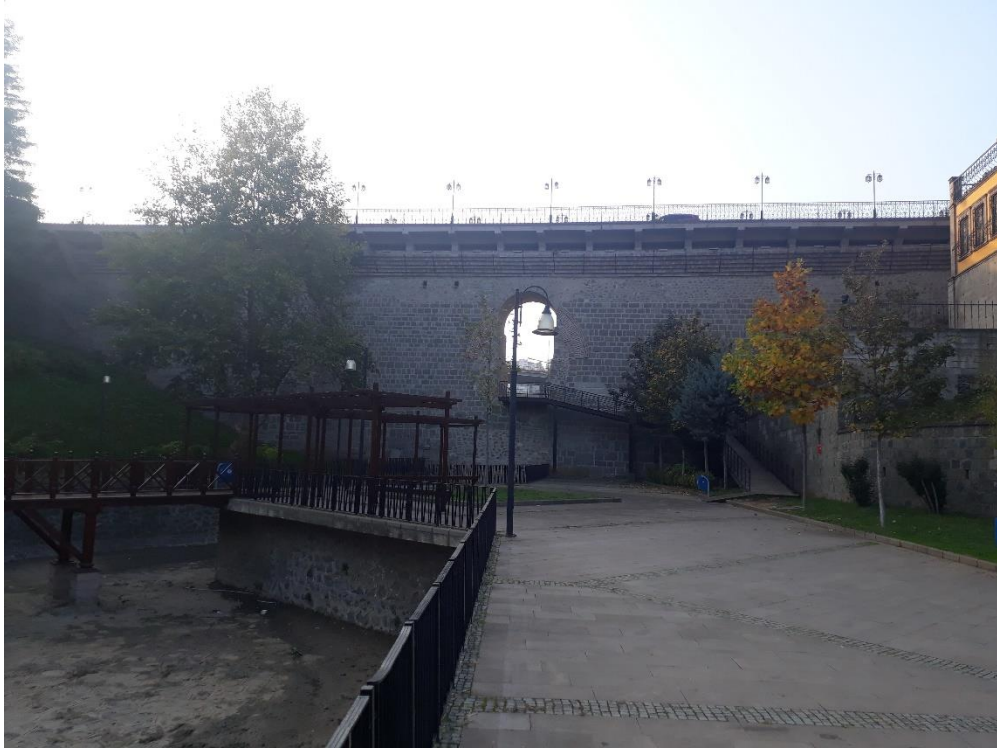
Fotoğraf 259: Zağnos Köprüsü. Kuzey cephe genel görünüş.
