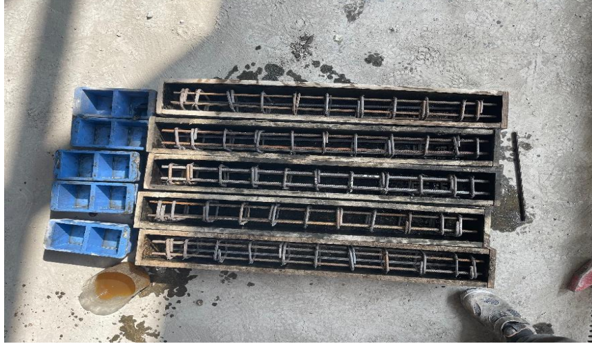
Şekil 3.5. Betonarme kiriş numuneleri için hazırlanan donatı kafeslerinin kalıplara yerleştirilmesi ve küp kalıpları
