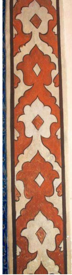
Resim 54. Şehzade Mustafa Türbesi, Duvar (E) Kemer Karnı Tezyînâtı
