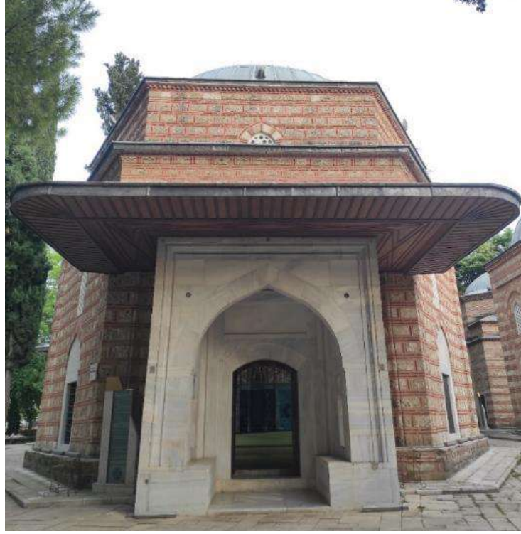
Resim 5. Cem Sultan Türbesi
