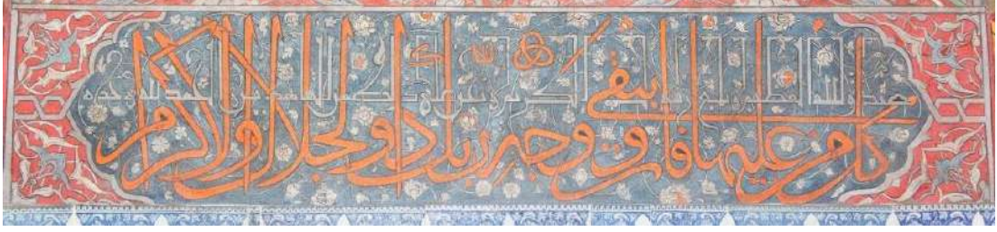
Resim 85. Duvar (B), Kartuş Kalem İşi Tezyînât
