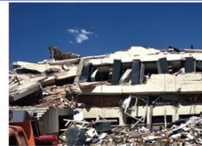
Fotoğraf 3: Mayıs 2003, Bingöl Depremi'nde yıkılan Çeltiksuyu YİBO
