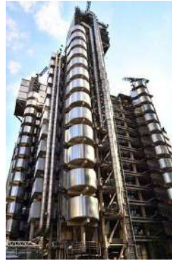
Fotoğraf 2.39. Llyod's Binası, (Web İletisi 46)
