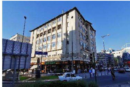
Fotoğraf 3.75. Maarif Kavşağından Görünüş, 2020
