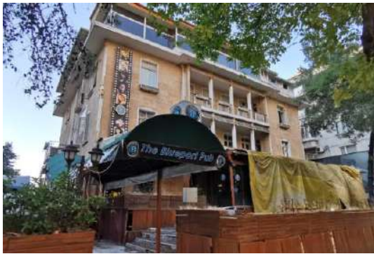
Fotoğraf 3.106. Ersoylar Apartmanı Atatürk Bulvarı Cephesi, 2020
