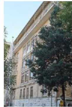
Fotoğraf 3.107. Ersoylar Apartmanı Atatürk Bulvarı Cephesi, 2020
