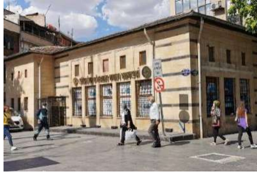
Fotoğraf 3.103. İl Halk Kütüphanesi Gaziler Caddesi Cephesi, 2020
