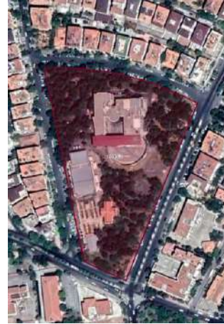
Şekil 3.11. Uydu Görüntüsü, 2021 (Yıkılan Verem Hastanesi Yerine Yapılan Şahinbey İlçe Belediye Binası (Web İletisi 76)).
