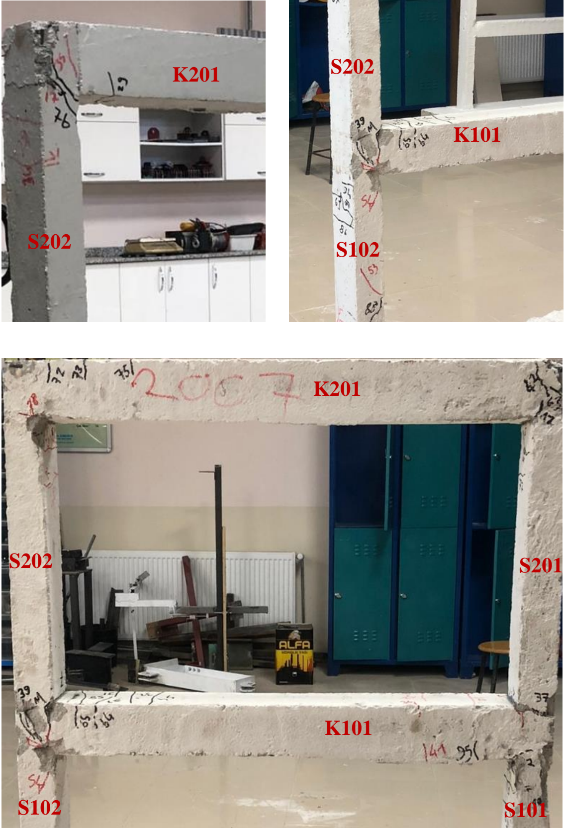
Şekil 4.22. Deney numunesi 2'nin, göçme konumunda kolon-kiriş birleşim bölgelerinde oluşan hasarlar
