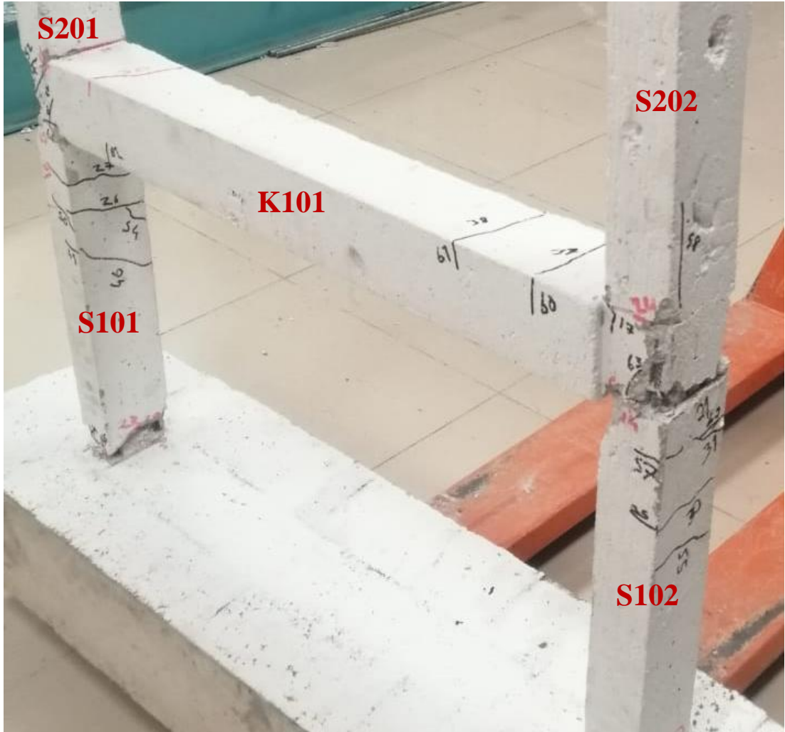
Şekil 4.10. Deney numunesi 1'in, göçme konumunda kolon-kiriş birleşim bölgelerinde oluşan hasarlar
