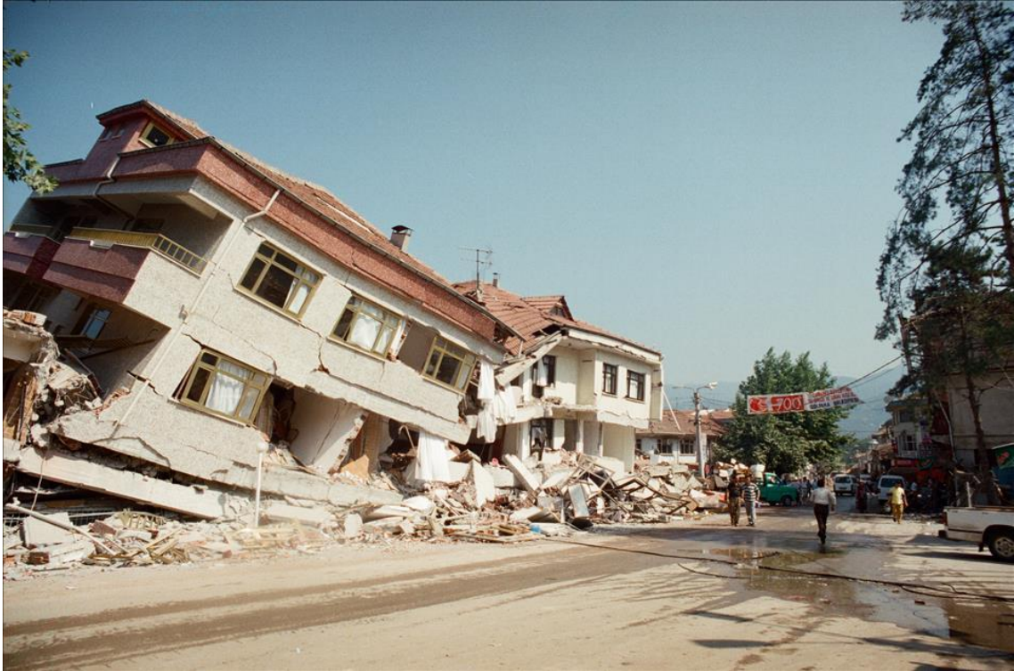
Şekil 1.3. 1999 Gölcük depremi sonrası yapılarda oluşan hasarlar (Gürbüz, 2015)
