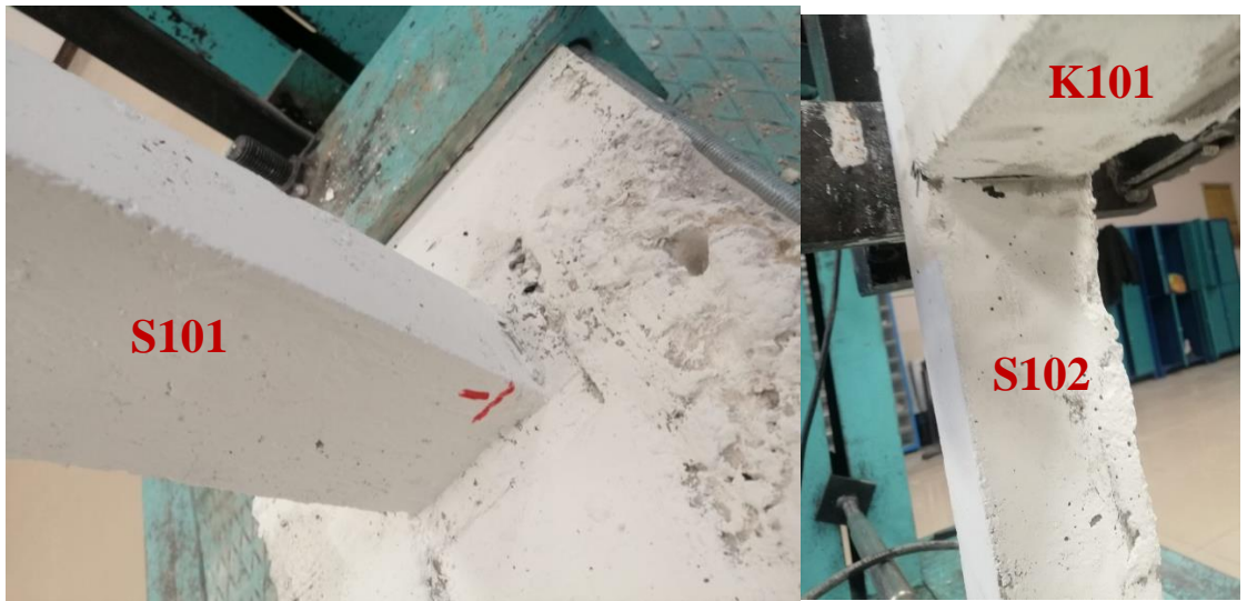
Şekil 4.18. Deney numunesi 2'de, itme ve çekme çevrimlerinde oluşan ilk çatlaklar
