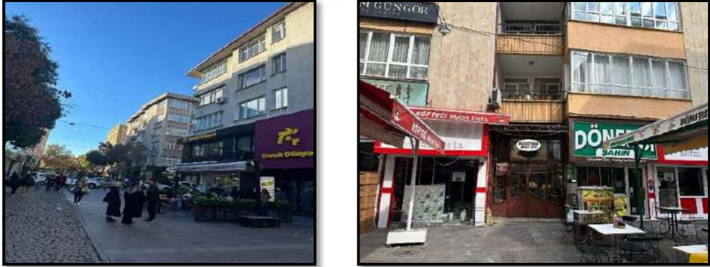
Şekil 4. 18. Araştırma alanında bulunan yapıların görünümü (Orijinal,2024)
