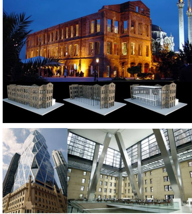
Şekil 2. Fasadizm yaklaşımıyla tasarlanmış yapılar, Esmâ Sultan Yalısı, İstanbul (Yukarıda), (URL-12), Hearst Tower, New York (Aşağıda), (Bloszies, 2011).
