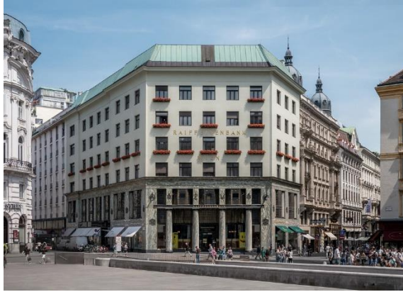
Şekil 20. Goldman&Salatsch Binası, Adolf Loos, 1910 (URL-2)
