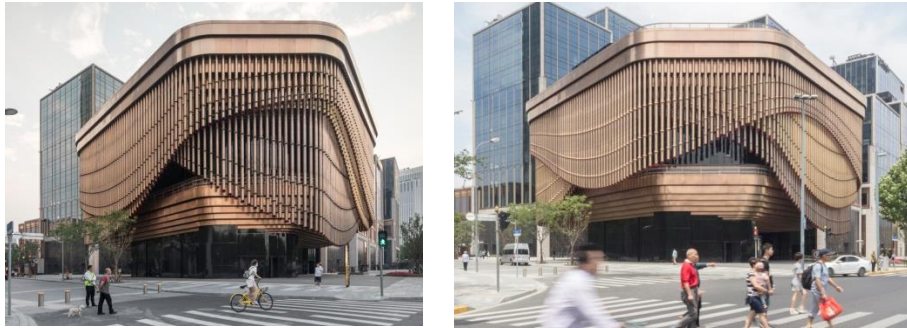
Şekil 6. Bina cephesinin hareket etmesi-Bund Finance Center (URL-3).
