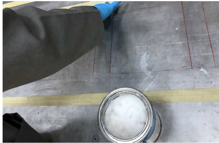
Şekil 3.17. Kalıp ayırıcının yüzeye uygulanması
