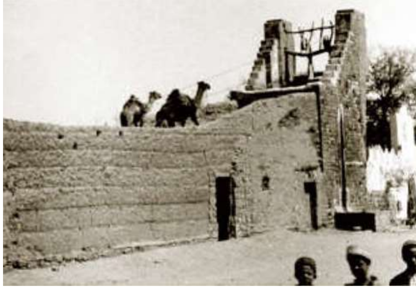
Resim 162: Talha Camii Güney Cephesindeki Kuyu (Us'us Et-Tesmim El-Mimari -2005).
