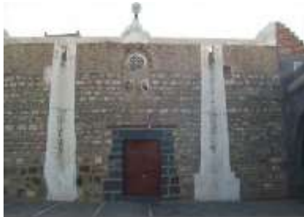
Resim 60: El-Müzzehhep Camii Batı Duvarındaki Güneybatı Girişi (Mohammed ANEB-2014).
