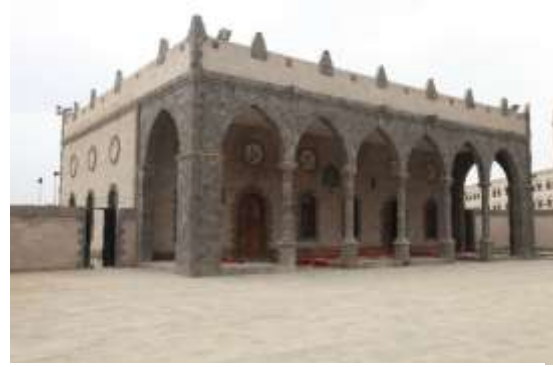
Resim 168: El-Urdi Camii Güney Cephesinin Görünüşü ( Ahmet KUŞ 2011 ).
