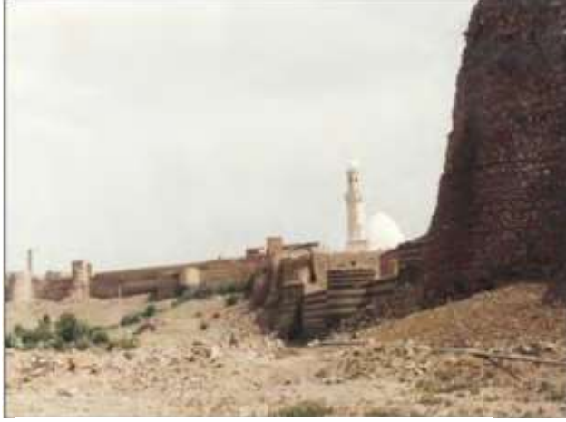
Resim 26: Muradiye Camii Genel Görünüşü (Mohammed ANEB 2014)
