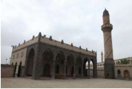
Resim 167: El-Urdi Camii Güney Cephesinin Görünüşü ( Ahmet KUŞ 2011 ).
