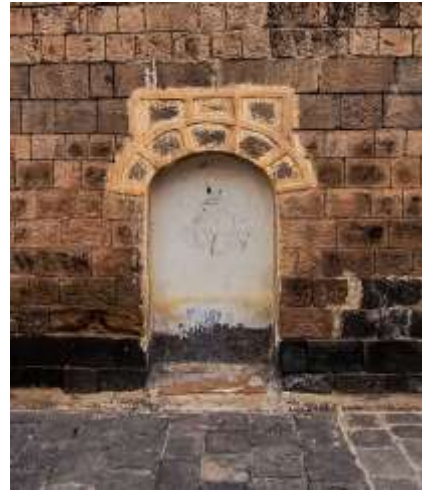
Resim 159: Talha Camii Avlunun Kuzey Duvardaki Nişi (Saeed MOHAMMED 2023).
