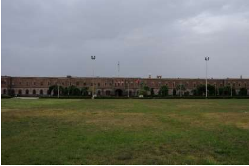
Resim 233: El-Urdi Manzumesi İkinci Kışlanın Ana Cephe Görünüşü (Ahmet KUŞ 2011).
