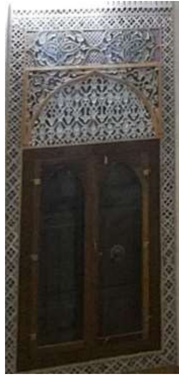
Resim 103: Bakiriyye Camii Harimin Doğu Duvar Penceresi (Saeed MOHAMMED -2023).
