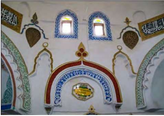
Resim 35: Muradiye Camii Kubbe Kasnağında Açılan Pencereleer ( Mohammed ANEB-2014).
