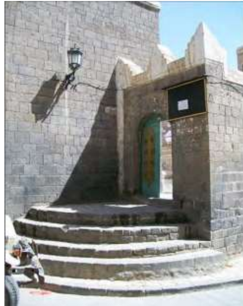
Resim 131: Talha Camii Kuzey Cephesin Giriş Kapısı (Saeed MOHAMMED 2023).
