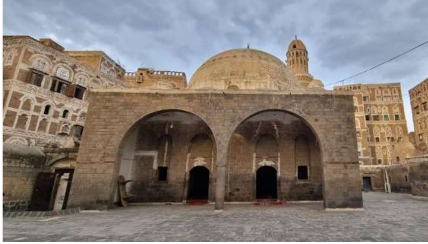
Resim 156: Talha Camii Revakı Genel Görünüşü (Saeed MOHAMMED 2023).
