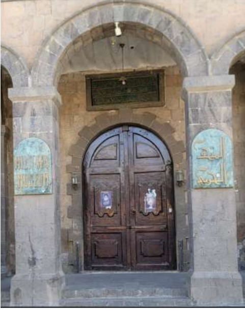
Resim 194: Sanayi Okulu Kuzey Cephesi Ana Girişi (Saeed MOHAMMED 2023).
