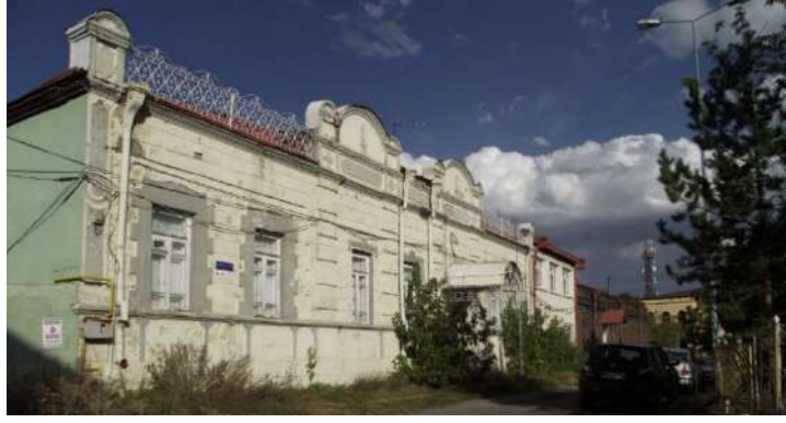
Resim 4.21. Maliye Caddesi 6 Numaralı Bina (Peker, 2013)
