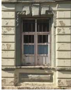
Resim 4.40a. Ahşap pencere (Peker, 2017)
