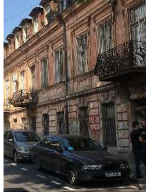
Resim 4.9b. Balkon korkuluğunun Tiflis'teki bir binada kullanımı (Peker, 2017)
