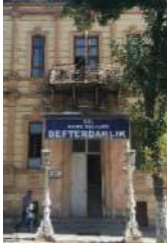
Resim 4.53a. Ahşap ana giriş kapısı (Peker, 2017)
