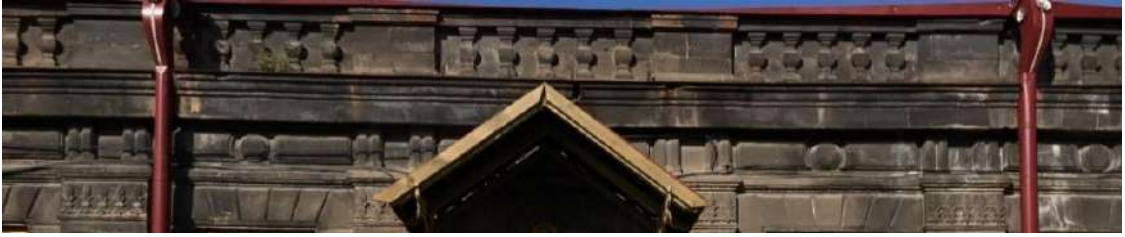
Resim 4.11. Kars Ticaret ve Sanayi Odası Binası saçaklık görünümü (Peker, 2017)
