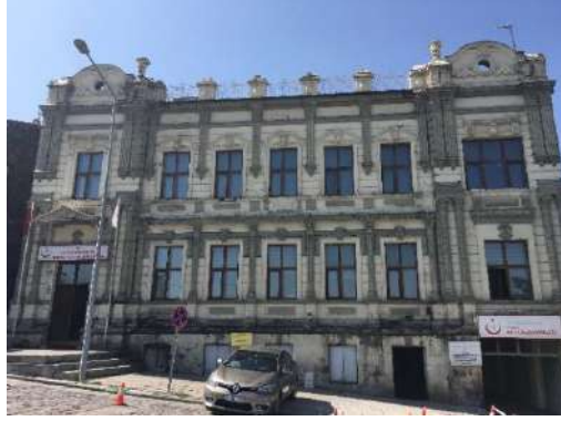
Resim 4.43. İl Sağlık Müdürlüğü Binası (Peker, 2017)
