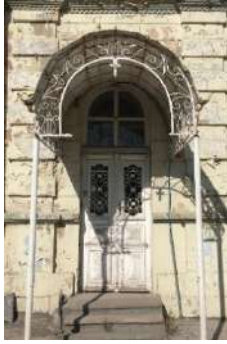
Resim 4.23. Ahşap kapı (Peker, 2017)
