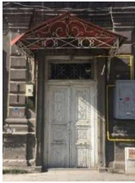
Resim 4.32. Ahşap kapı (Peker, 2017)
