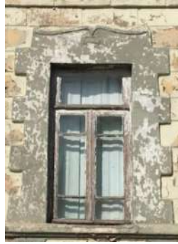
Resim 4.24. Ahşap pencere (Peker, 2017)
