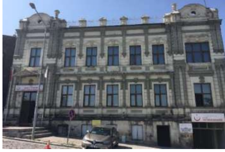
Resim 3.24. İl Sağlık Müdürlüğü Binası (Peker, 2017)
