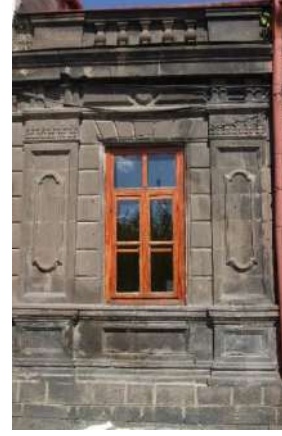
Resim 4.13. Ahşap pencere (Peker, 2017)
