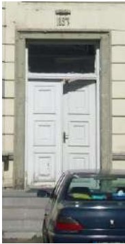
Resim 4.49a. Ahşap giriş kapısı (Peker, 2017)
