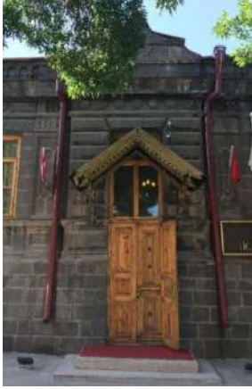
Resim 4.12a. Ahşap ana giriş kapısı (Peker, 2017)
