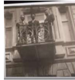
Resim 4.52. Balkon detayı (web iletisi-28)
