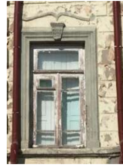
Resim 4.25. Ahşap pencere (Peker, 2017)
