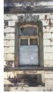
Resim 4.28. Ahşap pencere (Peker, 2017)
