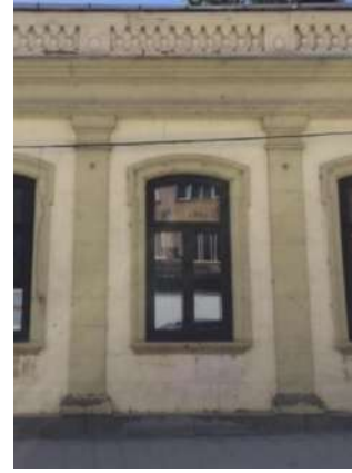
Resim 4.36. Ahşap pencere (Peker, 2017)
