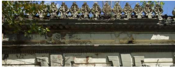
Resim 4.29. Kamuran Erenğüç Evi'nin saçaklık bezemeleri (Peker, 2017)
