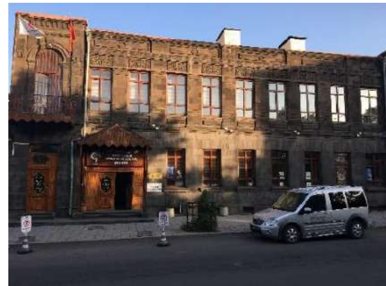
Resim 4.4. Kars'ta bir yapı (Peker, 2017)
