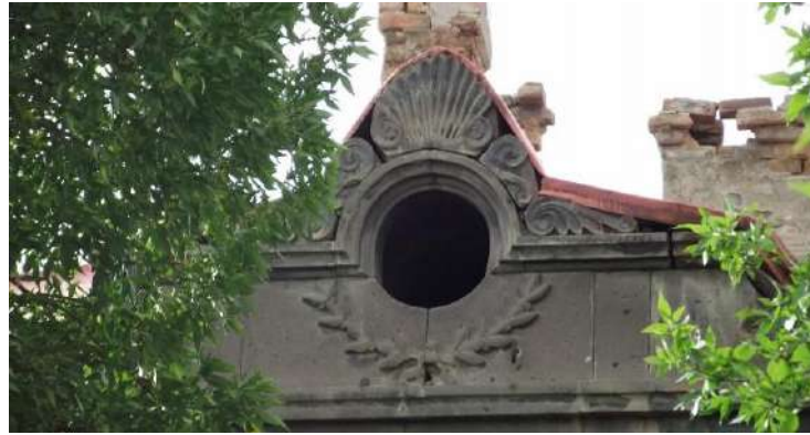
Resim 4.16. Ana giriş cephesi üzeri akroter kullanımı (Peker, 2013)
