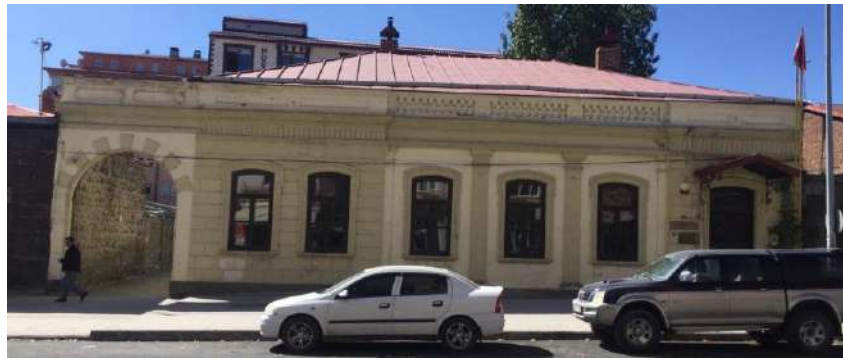
Resim 4.34. Kars-Ardahan Bölge Barosu Binası (Peker, 2017)
