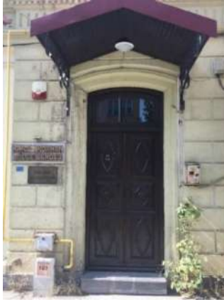
Resim 4.35. Ahşap kapı (Peker, 2017)
