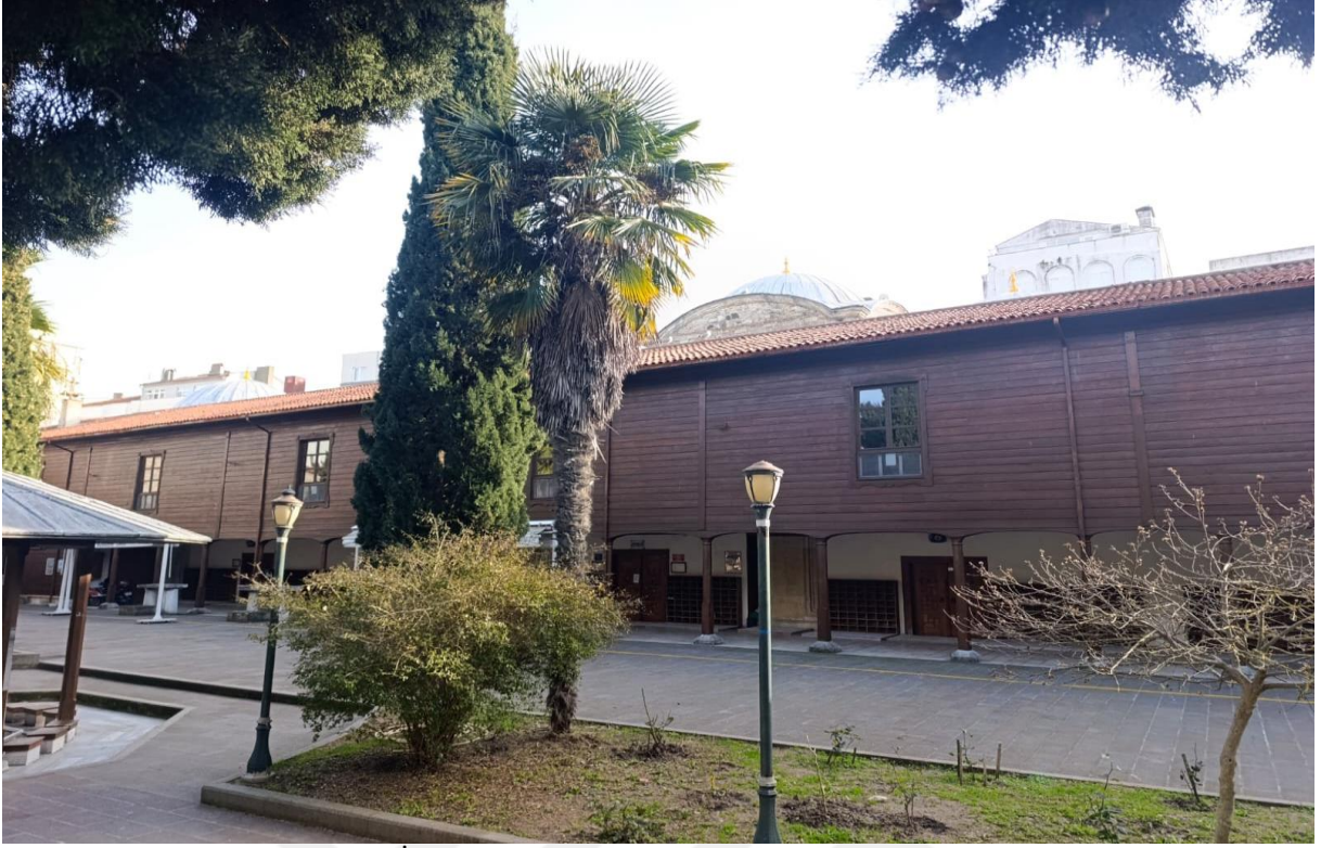
Görsel 4.5. Sinop Alaaddin Cami İç Avlusu (Fotoğraf tarafımızdan çekilmiştir.)
