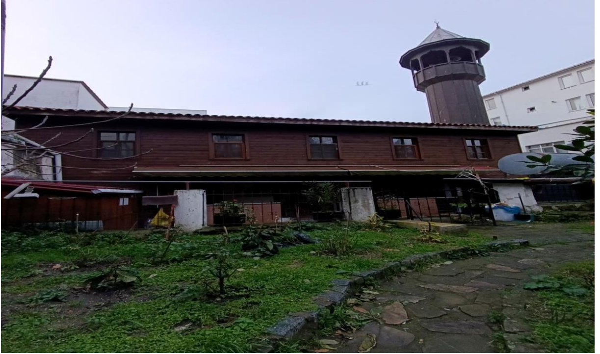
Görsel 4.3. Sultan Süleyman Camisi arka cephesi (Resim tarafımızdan çekilmiştir.)
