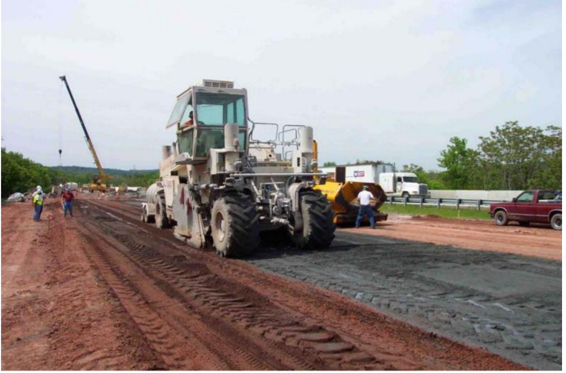
Şekil 2.23. Uçucu kül ile zeminin karıştırılması işlemi (Beeghly, 2003).
