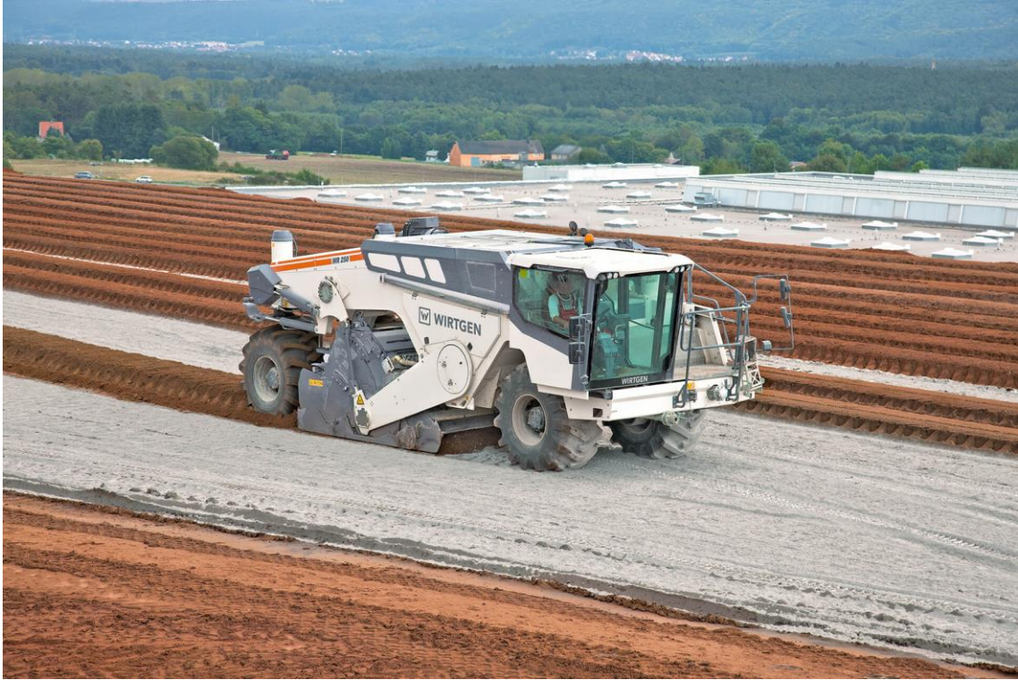
Şekil 2.14. Sahada kireç ile zemin stabilizasyonu
