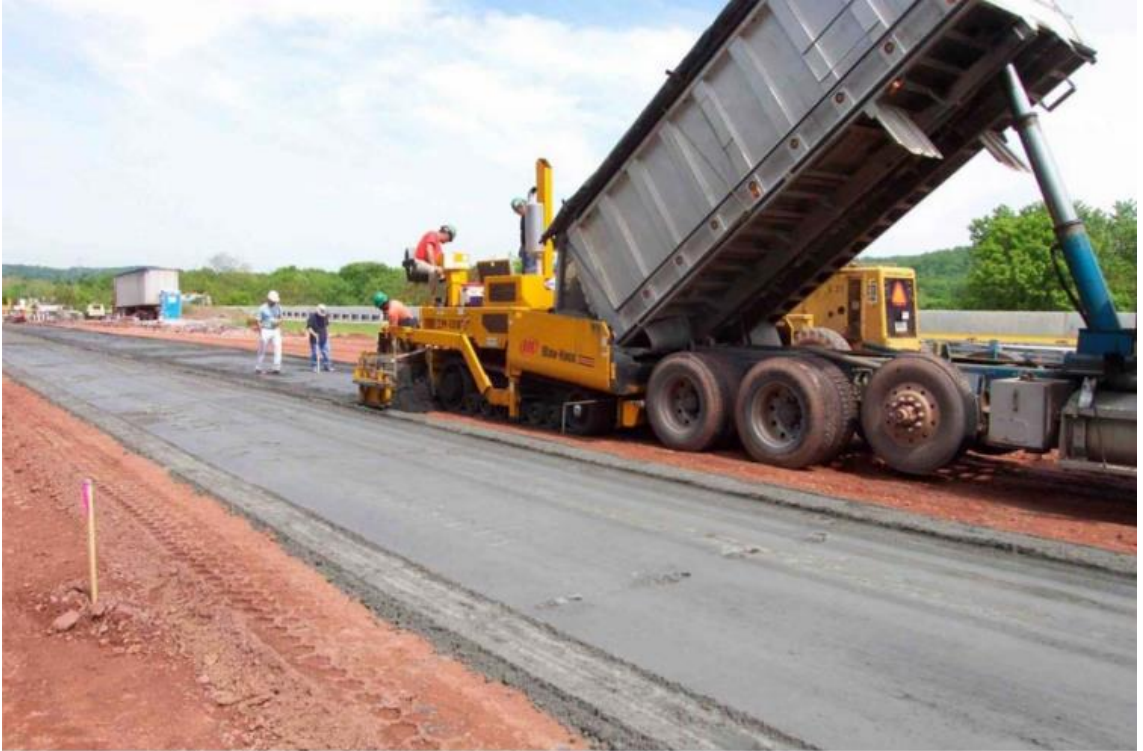
Şekil 2.22. Uçucu külün zemine serilmesi işlemi (Beeghly, 2003).
