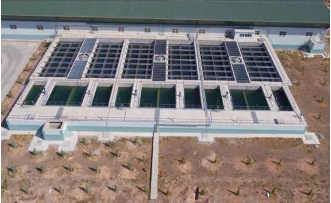
Şekil 2.4. Yavaş karıştırma ve durultucu üniteleri
