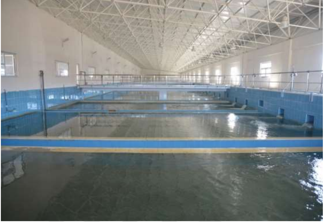
Şekil 2.5. Hızlı kum filtreleri
