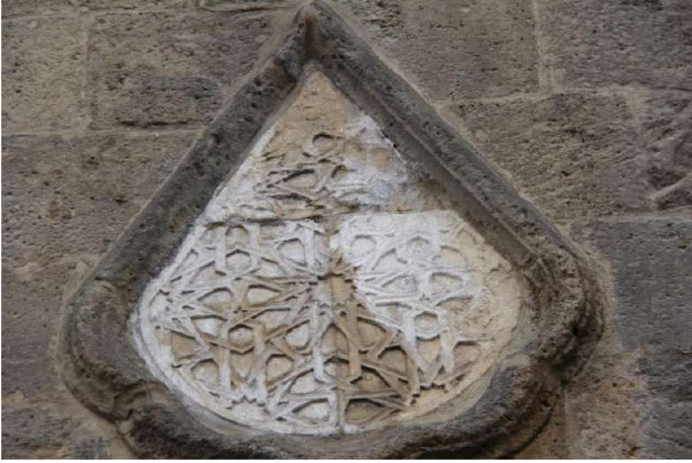
Fotoğraf 19: Bitlis Şerefiye Camii Doğu Duvarındaki Damla Biçimli Madalyon (Resul Yelen'den)
