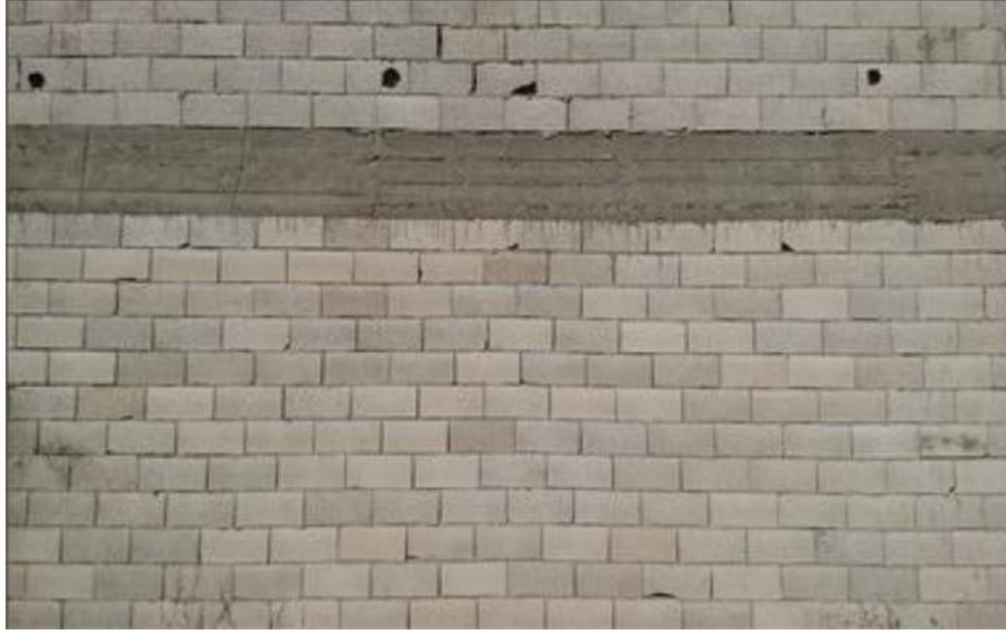
Şekil 3.7: Briket Duvarlı Yığma Yapı (Yalnız, 2020)
