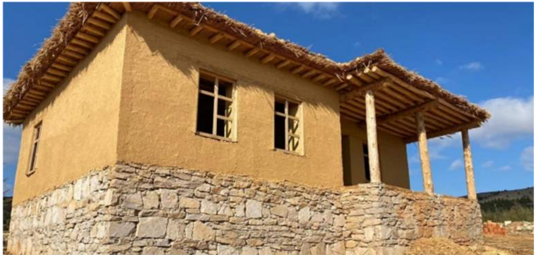
Şekil 3.5: Altı Taş Üstü Kerpiç Duvarlı Yığma Yapı (URL2)
