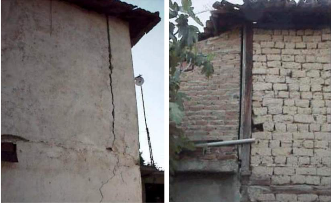
Şekil 3.23 Sismik etkide oluşan ayrışmalar (Çırak, 2011).
