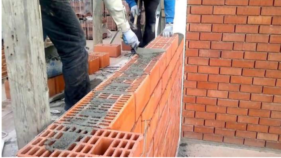
Şekil 3.2: Yığma Tuğla Duvarı (URL1)
