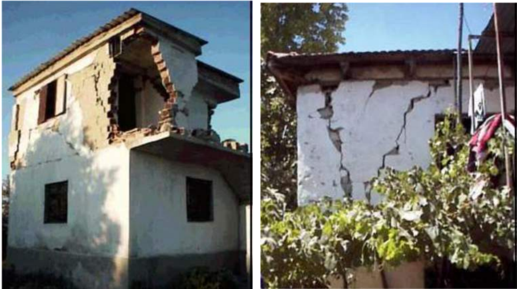
Şekil 3.13: Yığma duvarda hasar biçimleri (Sucuoğlu, 1997)
