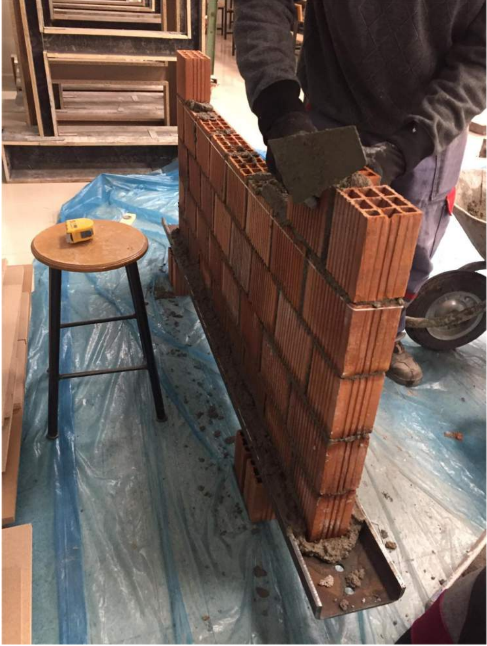
Şekil 4.2: Üretilen tuğla duvar deney numuneleri
