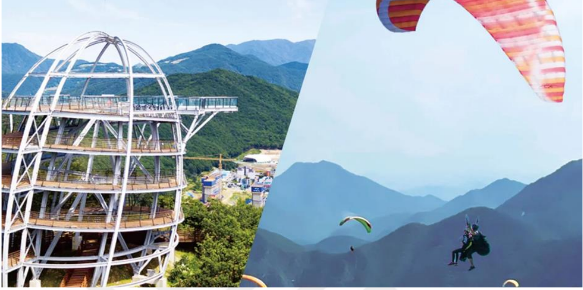
Fotoğraf 3.37. Mancheonha skywalk gözlemevi
