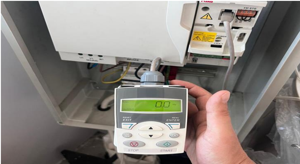
Şekil 5.18. Rüzgar tüneline fan motorunu devir sayısı ayarı için kullanılan sürücü (frekans konvertörü) kumandası
