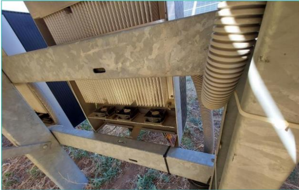
Şekil 3.27 Evirici topraklama bağlantısı
