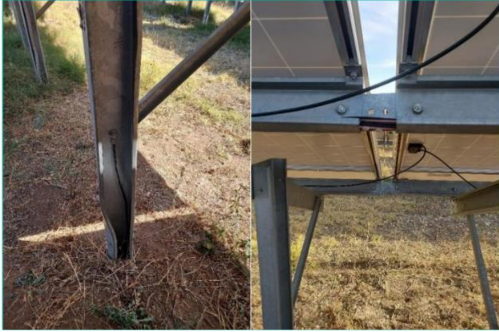
Şekil 3.26 Taşıyıcı sistem topraklama bağlantıları
