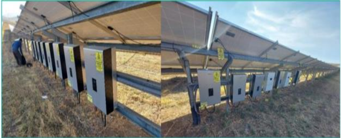
Şekil 3.33 Evirici montaj detayı
