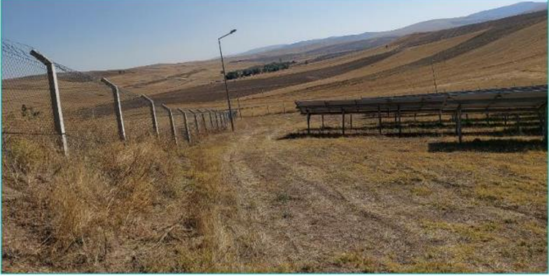
Şekil 3.25 Santralin kurulu olduğu zemin ve çevre yolları
