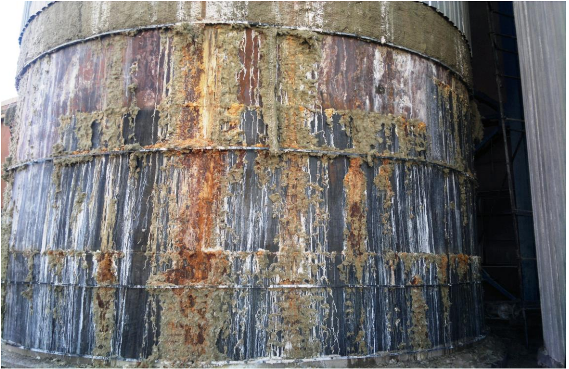
Şekil 4.1. Düzenlenmiş dönüş çözeltili tankı kostik kaçakları
