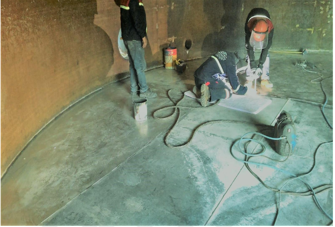
Şekil 4.3c. Tank içi AISI 316 paslanmaz çelik kaplama çalışması 2mm
