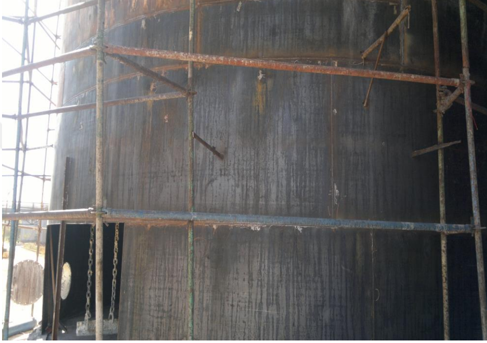
Şekil 4.3c. St37-2 çeliği tank imalatı
