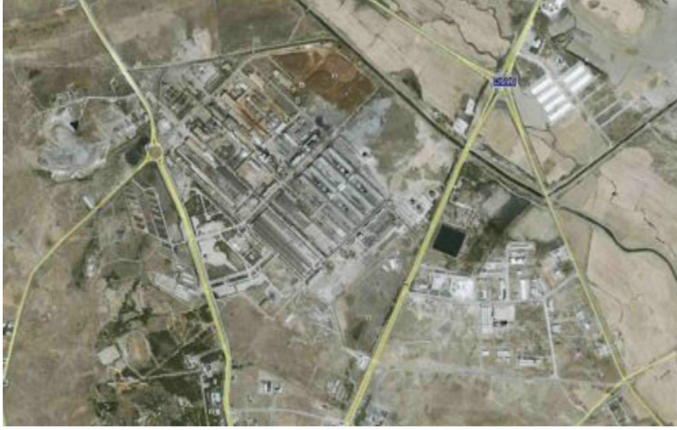
Şekil 1.1. Seydişehir Eti Alüminyum Tesisleri
