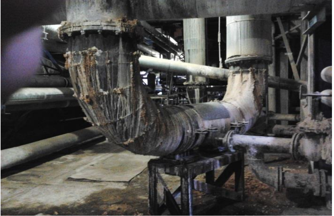
Şekil 4.7. 1.Batarya aparat kuvvetli çözelti flaş tankı 812 çıkış boru hattı
