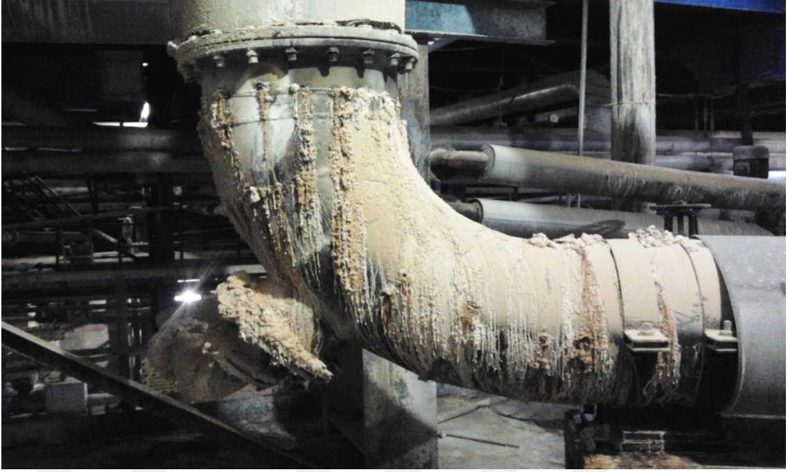
Şekil 4.8. 1.Batarya aparat kuvvetli çözeltili flaş tankı 812 çıkış boru hattı dirseği
