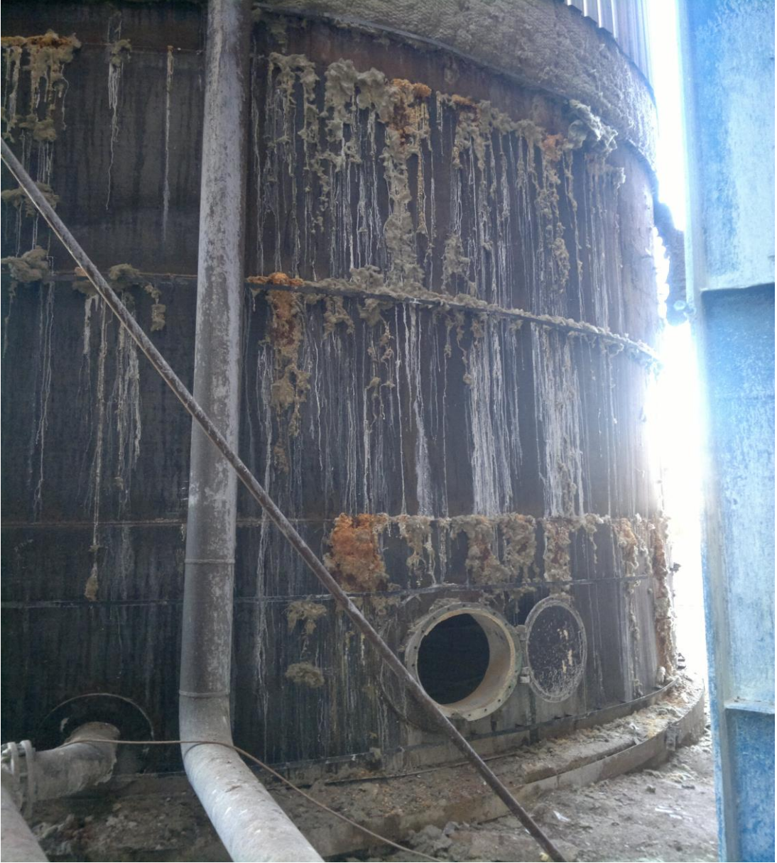
Şekil 4.4. Östenitik paslanmaz çelik ile kaplanmış çözelti tankı kostik kaçaqları
