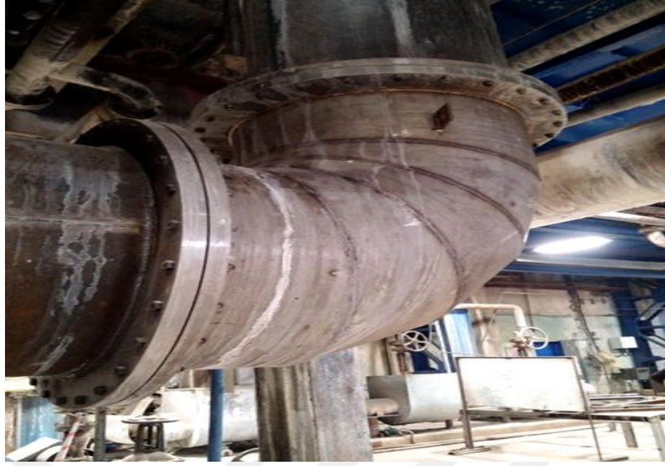
Şekil 4.12. 1.Buharlaştırma 1.aparat (809) alt yarı dirseği A1sı 316 paslanmaz çelik
