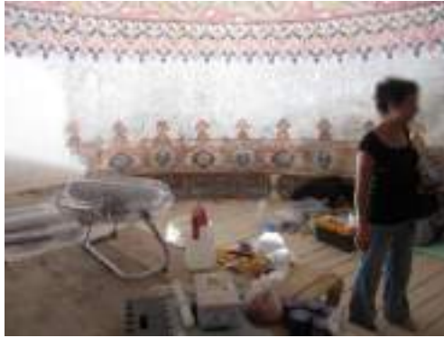
Gülrûh Hatun Türbesi, Restorasyon Aşaması, Kubbe Tezvinât İhyası
