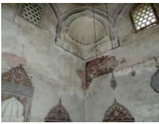
Mükrime Hatun Türbesi, Duvar Yüzeyi Tez- yinatı
