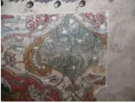
Gülrûh Hatun Türbesi, Restorasyon Aşaması, Kubbe Sıva Raspası 1
