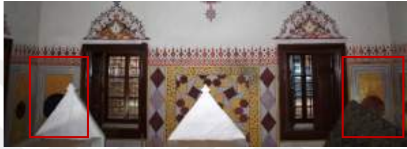
Resim 204: Mükrimme Hatun Türbesi, Batı Duvarı, Mermer Taklit Tezyinâtı
