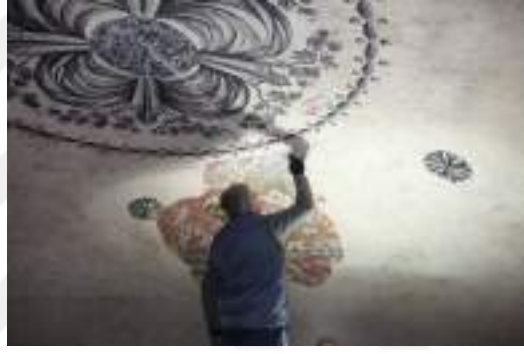
Gülrûh Hatun Türbesi, Restorasyon Aşaması, Kubbe Sıva Raspası 2
