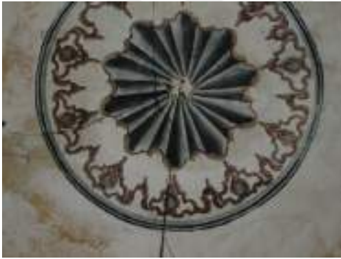
Şirin Hatun Türbesi, Restorasyon Öncesi Kubbe Tezvinâtı
