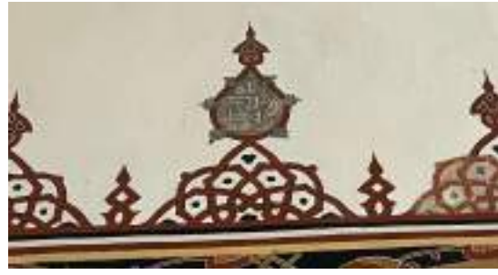
Resim 266: Mevlana Türbesi, Doğu Duvarı
