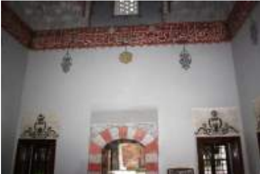
Resim 242: Gülrûh Hatun Türbesi, Doğu Duvarı
