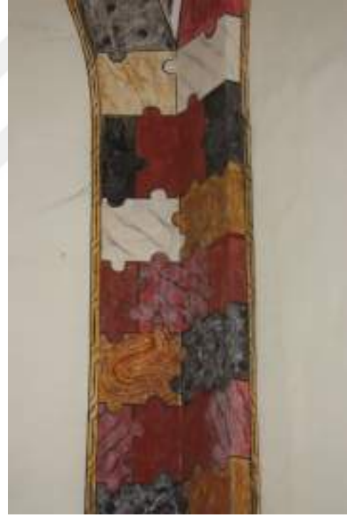
Resim 53: Hüma Hatun Türbesi, Mermer Taklit Uygulama Detay
