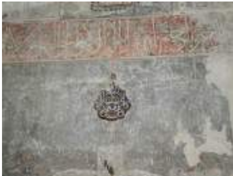
Şirin Hatun Türbesi, Duvar Yüzeyi
