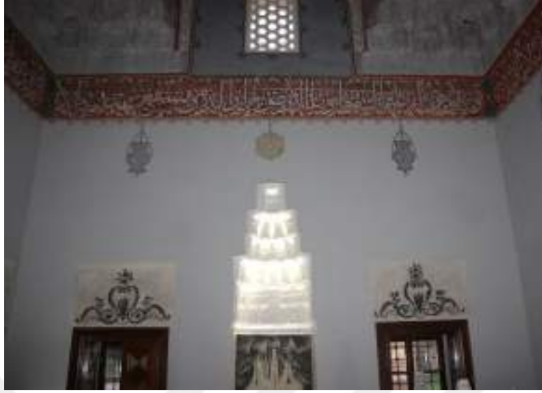
Resim 33: Gülrûh Hatun Türbesi, Güney Duvarı
