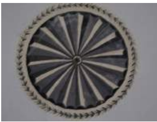
Gülşah Hatun Türbesi, Restorasyon Öncesi Kubbe Tezvinâtı
