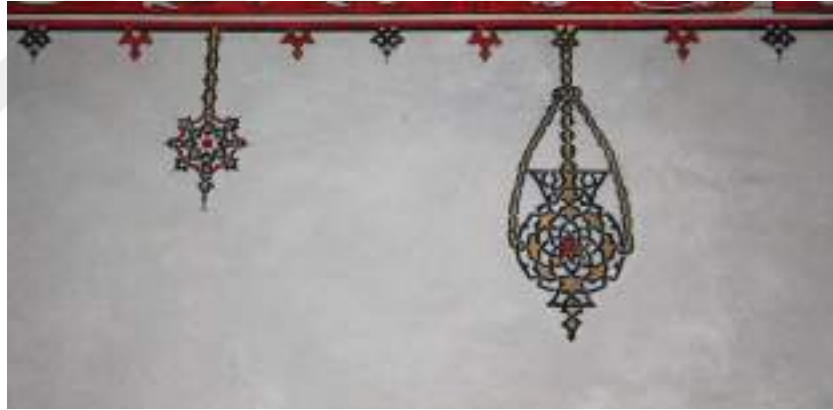
Resim 172: Mükrim Hatun Türbesi, Güney Duvarı Kalemîşi Tezyinâtı Detay
