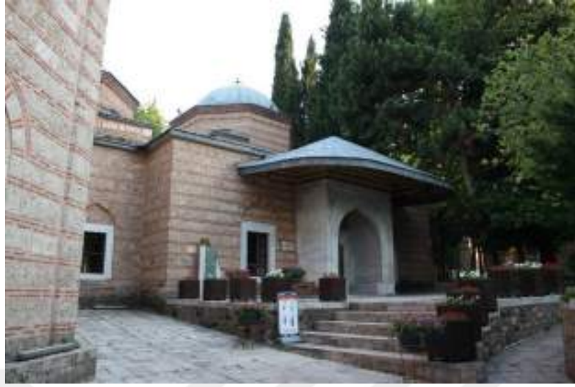
Resim 8: Sultan II. Murad Türbesi
