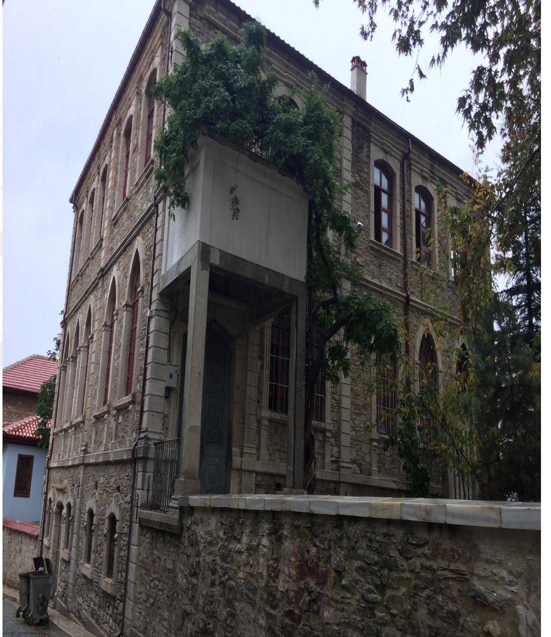
Fotoğraf-6: Gazi Mustafa Kemal İlkokulu binasının yan cepheden görünümü. 25/10/2018 tarihinde tarafımızdan çekilmiştir.
