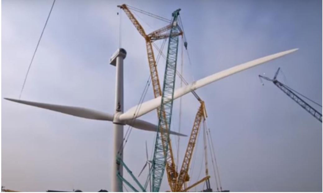
Şekil 1.9. Rüzgar Türbin kanatlarının kule'ye kaldırılması
