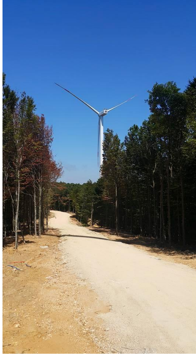
Şekil 4.4. Beşiktepe rüzgar türbin görünümü
