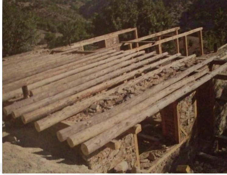
Resim 78: Anadolu’da inşaat halindeki evin çatı hatıllarına ait bir örnek (Ünal, 2016: 233)
