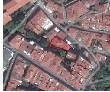
Apartmanın konumu, 2019 (Web İletisi 49) Adres: Vişnezade Mahallesi, Maçka Meydanı Sokağı, No:4 Beşiktaş/İstanbul
