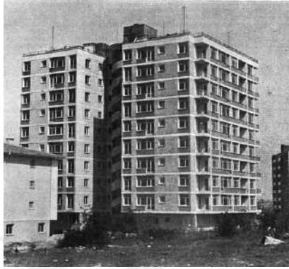
Resim 2.15. Emel Yapı Kooperatifi Blok Apartmanı arka cephe (Anonim, 1965)
