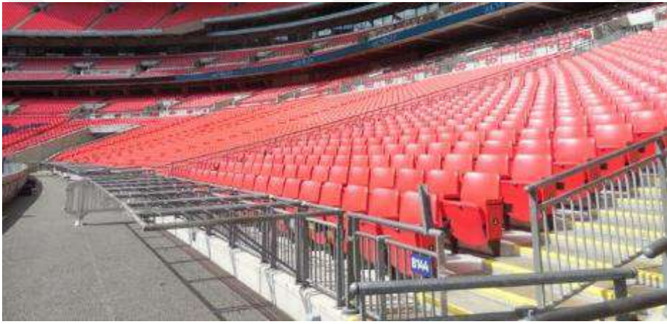
Şekil 4.43. Wembley Stadyumu'nda (İngiltere) Yatay Tel Örgü Uygulaması 93
