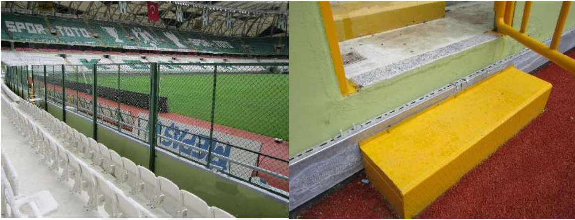
Şekil 5.33. Kuzey Tribünlerinde Tel Örgülü Sınırlayıcılar (solda) ve Tahliye Merdivenleri (sağda)
