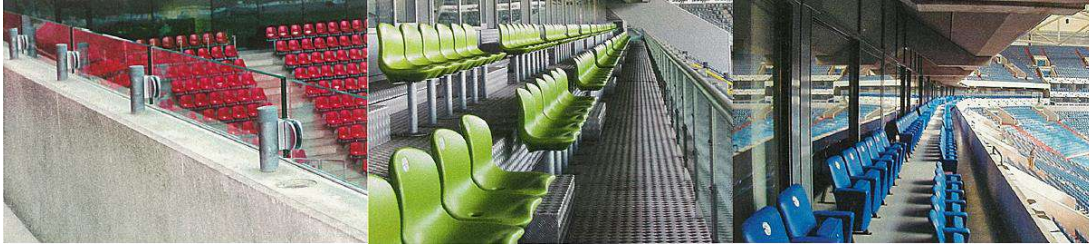
Şekil 4.27. Tribünlerde Korkuluk Kullanımları, Soldan Sağa; Yarı Geçirgen, Tam Geçirgen, Geçirimsiz Korkuluklar [23]
