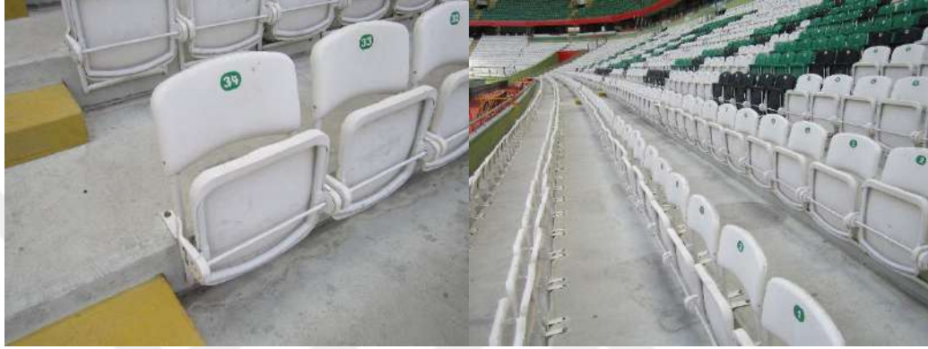
Şekil 5.31. Doğu Alt Tribünü Koltuklarının Görünümü
