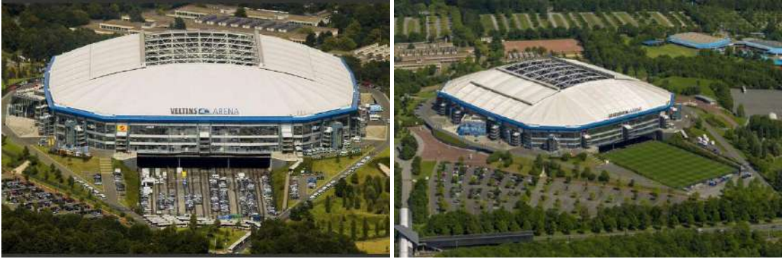
Şekil 3.52. Veltins Arena (Almanya) Stadyumu'nda Hareketli Saha Sistemi 59
