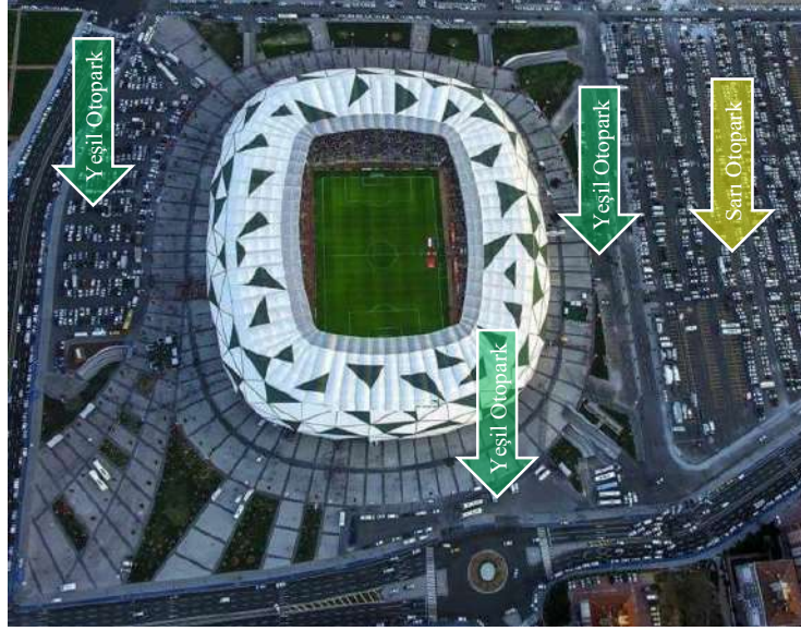
Şekil 5.38. Stadyum Otoparklarının Kaletaş Caddesi Cephesinden Görünümü 102
