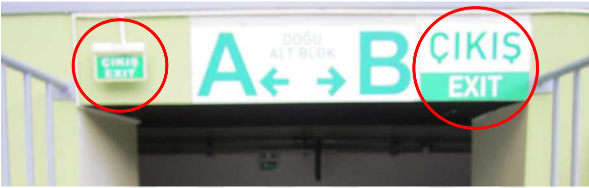
Şekil 5.24. Stadyum İçerisinde Acil Durum Çıkışlarını Gösteren Aydınlatmalı ve Aydınlatmasız Panolar
