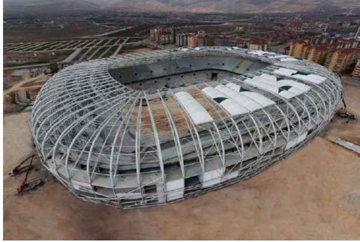
Şekil 5.42. Stadyum Cephesi Taşıyıcı Sistemi ve Kısmen Görülen Membran Uygulaması 103
