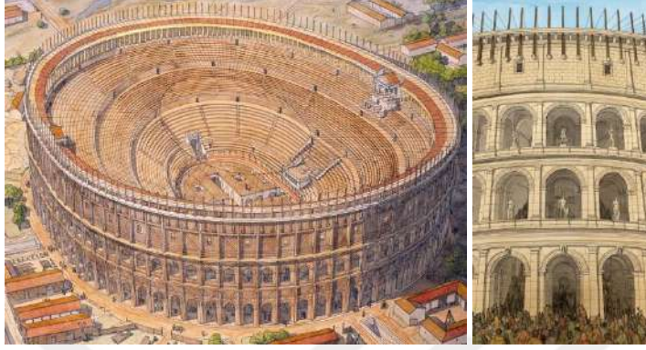
Şekil 3.22. Colosseum'da Kullanılan Velarium (solda) ve Bunu Taşıyan Direkler (sağda) 16
