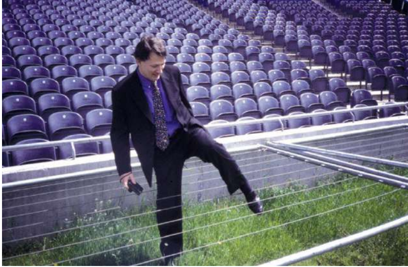
Şekil 4.42. Yatay Tel Örgü Uygulamasına Bir Örnek [33]
