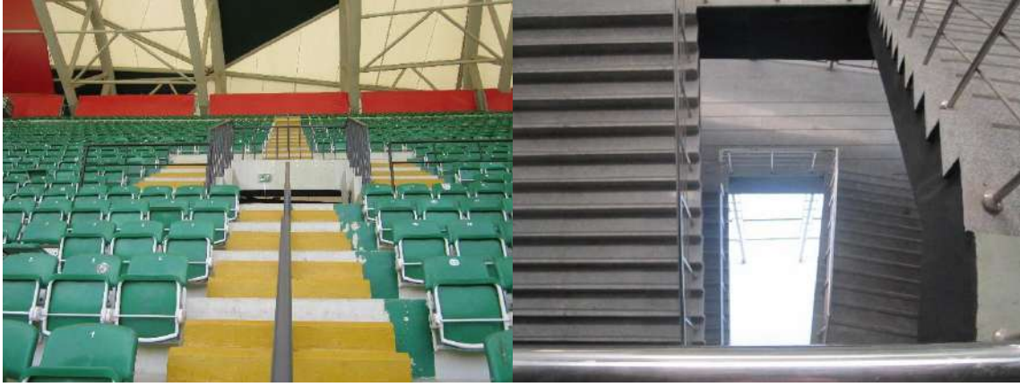
Şekil 5.55. Güney Üst Tribününde Fuayeye Açılan (1) (solda) ve Zemin Kata İnen (5) (sağda) Merdivenler
