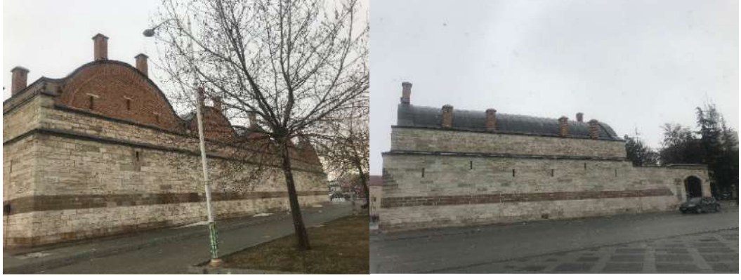
Şekil 6.2. Restorasyon sonrası Rüstem Paşa Kervansarayı kuzey cephesi(solda) ve batı cephesi(sağda) (Yazara ait fotoğraf arşivi, 2020-2022).
