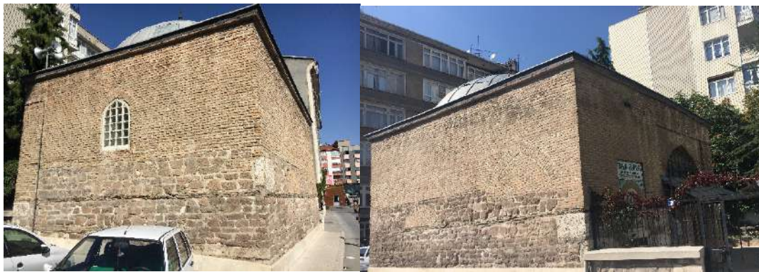
Şekil 3.33. Tahir ile Zühre mescidinin güneybatı doğu(solda) ve güneydoğu(sağda) cephesi (Yazara ait fotoğraf arşivi, 2020-2022)
