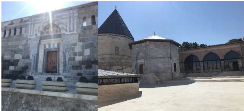
Şekil 3.6. Alâeddin Camii kuzey cephesi girişi(solda), avlunun içinden kuzey görünüşü (sağda) (Yazara ait fotoğraf arşivi, 2020-2022)
