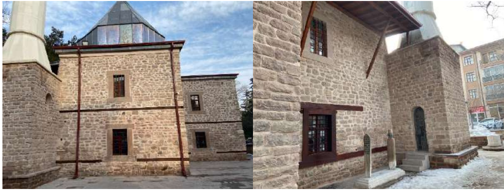
Şekil 3.47. Konya Şems-i Tebrizi Camii batı cephesi (solda) ve kuzey cephesi (sağda)(Yazara ait fotoğraf arşivi, 2020-2022).
