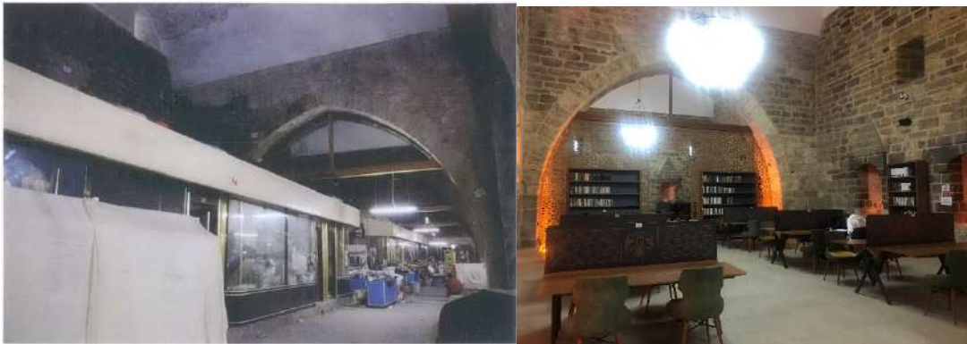
Şekil 6.11. Restorasyon öncesi Rüstem Paşa Kervansarayı ahır bölümüne eklenen dükkânlar(solda) (KVBM arşivi, Restorasyon raporu, 2013) ve Restorasyon sonrası ahır bölümü (sağda) (Yazara ait fotoğraf arşivi, 2020-2022)
