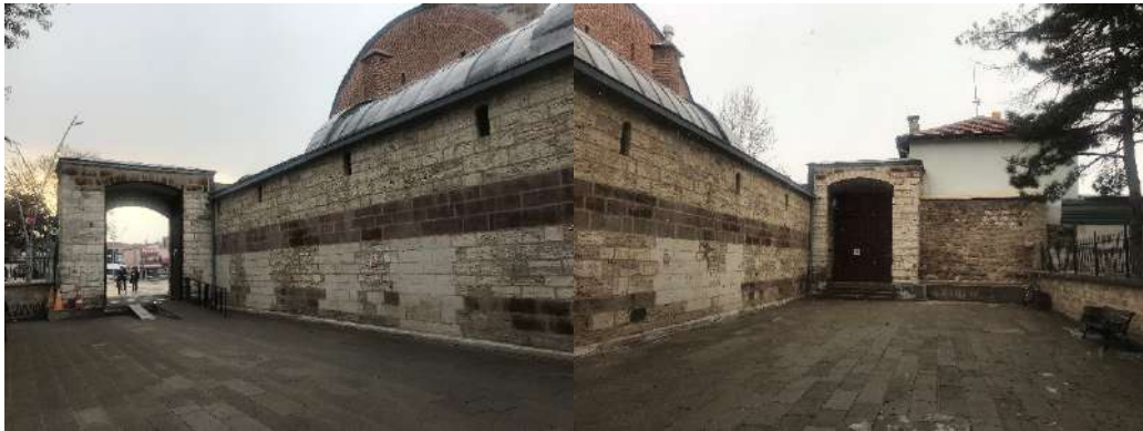
Şekil 3.54. Konya Ereğli Rüstem Paşa Kervansarayı avludan batı yönüne açılan Konya Kapısı iç görünüşü(solda) ve doğu yönüne açılan Bağdat Kapısı iç görünüşü (sağda)(Yazara ait fotoğraf arşivi, 2020-2022).
