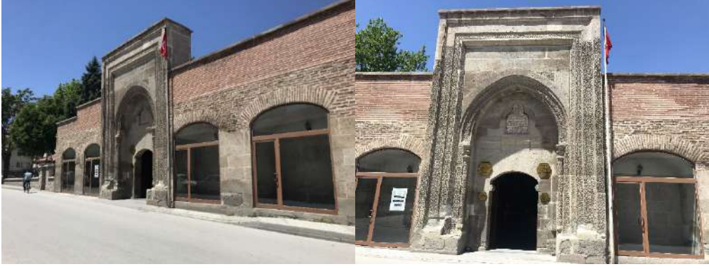
Şekil 3.25. Sahib-i Ata Külliyesi hankâh doğu cephesi ve dükkânlar (solda) ve hankâh giriş kapısı(sağda) (Yazara ait fotoğraf arşivi, 2020-2022)
