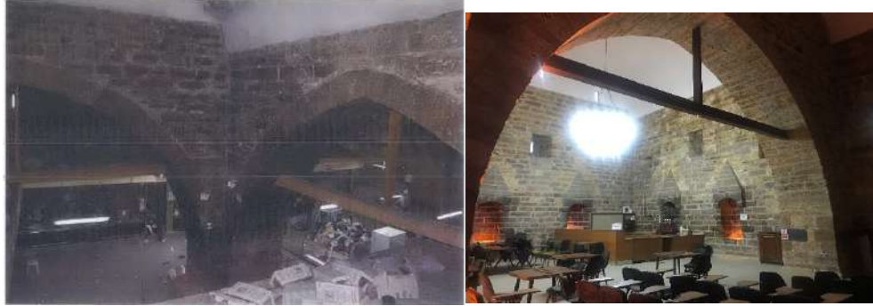
Şekil 6.13. Restorasyon öncesi Rüstem Paşa Kervansarayı kemerlerdeki ahşap gergiler(solda) (KVBM arşivi, Restorasyon raporu, 2013) ve Restorasyon sonrası kemerlerdeki ahşap gergiler(sağda)(Yazara ait fotoğraf arşivi, 2020-2022)
