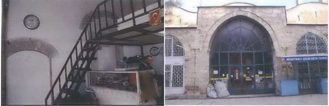
Şekil 6.12. Restorasyon öncesi Rüstem Paşa Kervansarayı dükkânlarında metal ve seyyar merdivenlerle çıkılan ara katlar(solda) ve dış dükkânlar önündeki ekler(KVBM arşivi, Restorasyon raporu, 2013)
