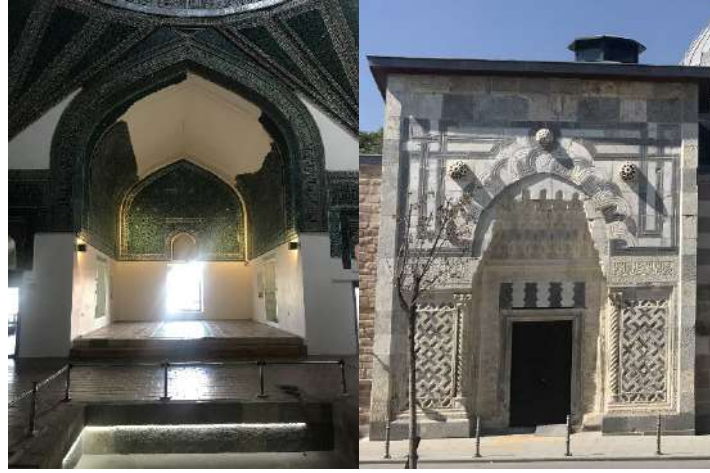
Şekil 3.15. Karatay Medresesi havuz (solda) ve taç kapısından görüşler (sağda) (Yazara ait fotoğraf arşivi, 2020-2022)
