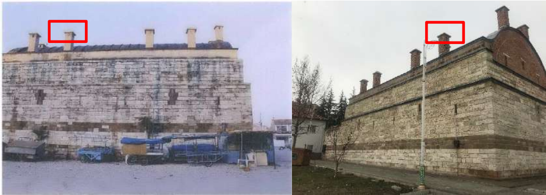
Şekil 6.4. Restorasyon öncesi Rüstem Paşa Kervansarayı doğu cephesinde bacalar üzerindeki beton şapkalar (solda) (Restorasyon raporu, 2013) ve Restorasyon sonrası tuğla şapkalar (sağda) (Yazara ait fotoğraf arşivi, 2020-2022)
