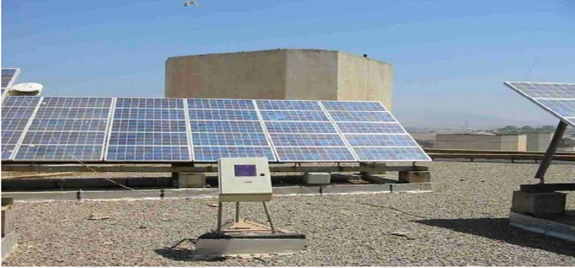
Şekil 2.1 Cezayir Bilim ve Teknoloji Üniversitesi'ndeki 1,4 kW'lık PV dizisi ve güneşte güneşlenme sensörü (Raza, 2014)
