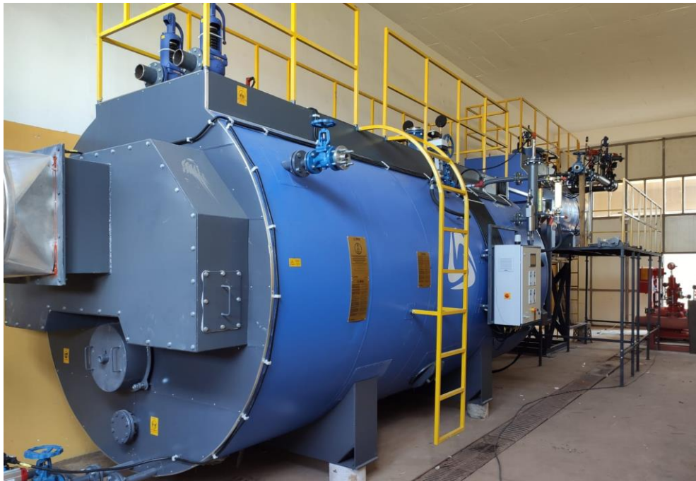
Şekil 3.1. İncelenen Buhar Kazanı Sistemi ve Yardımcı Ekipmanları
