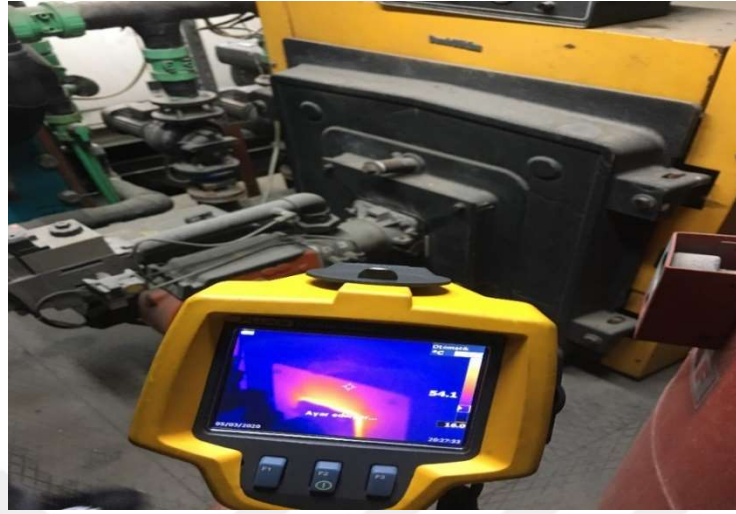
Şekil 4.2. Sıcak su kazanı
