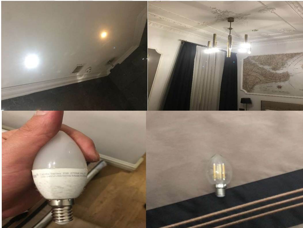
Şekil 4.15. Enerji Etüdü Yapılan Otel İşletmesindeki LED Armatürler
